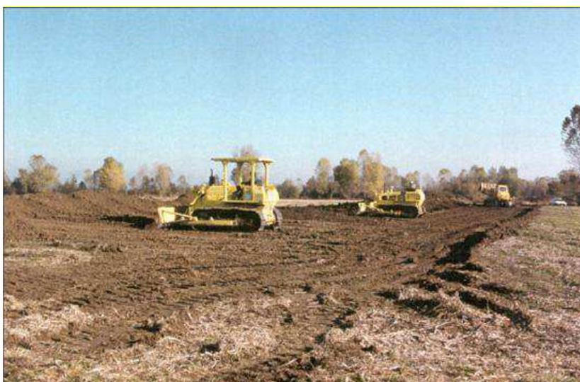
**Figura 3.b: Operazioni Tipiche di Apertura dell'Area di Passaggio**
