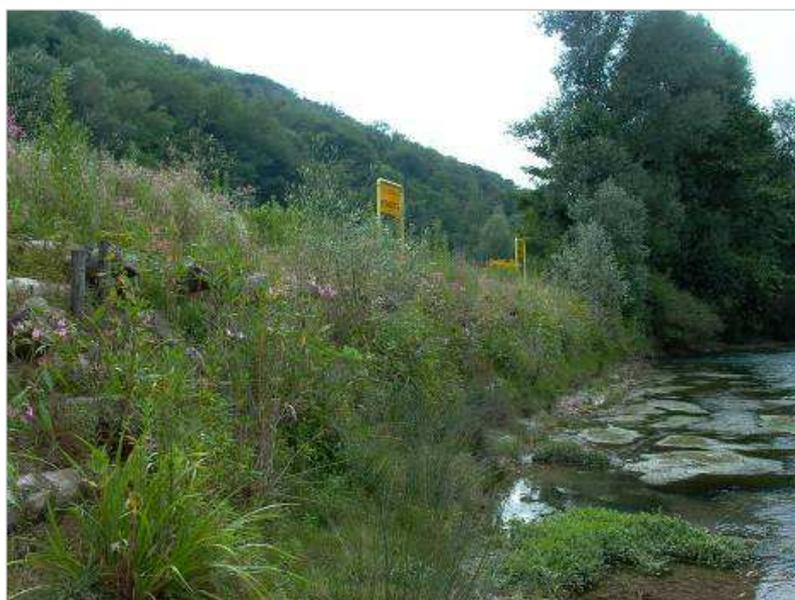
**Figura 3.i: Esempio di Riprofilatura con Palizzate in legname e Ripristino vegetazionale**
