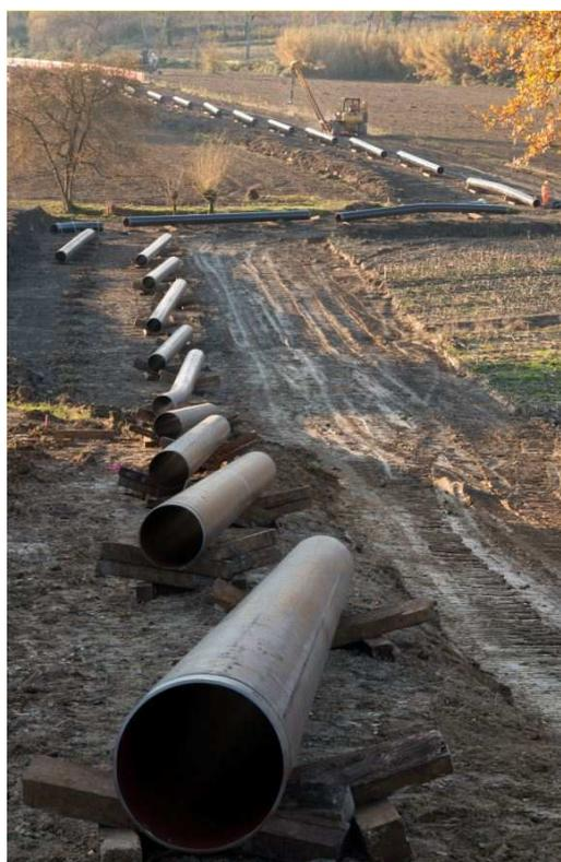
**Figura 3.c: Foto delle Tipiche Operazioni di Sfilamento tubazioni**
