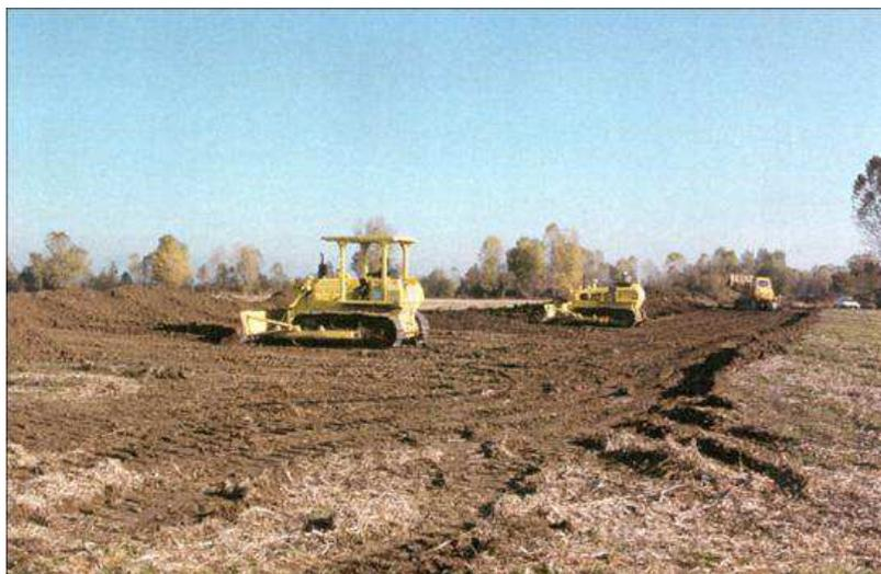
**Figura 5.b: Operazioni Tipiche di Apertura dell'Area di Passaggio**
