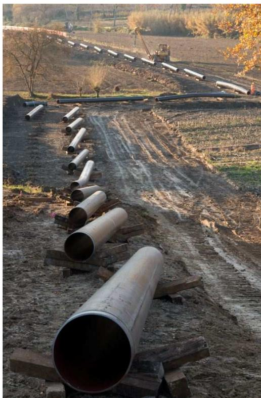
**Figura 5.c: Foto delle Tipiche Operazioni di Sfilamento tubazioni**
