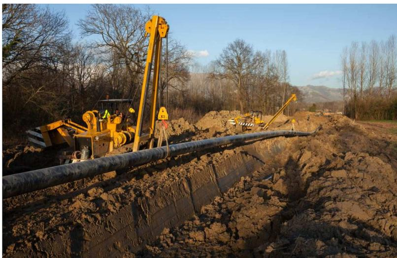
**Figura 5.e: Foto delle Tipiche Operazioni di Posa della Condotta**
