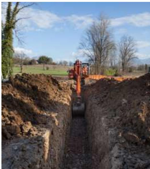
**Figura 5.d: Foto delle Tipiche Operazioni di Scavo della Trincea**
