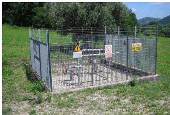
**Figura 5.h: Esempi di Punti di Intercettazione di Linea (PIL)**
