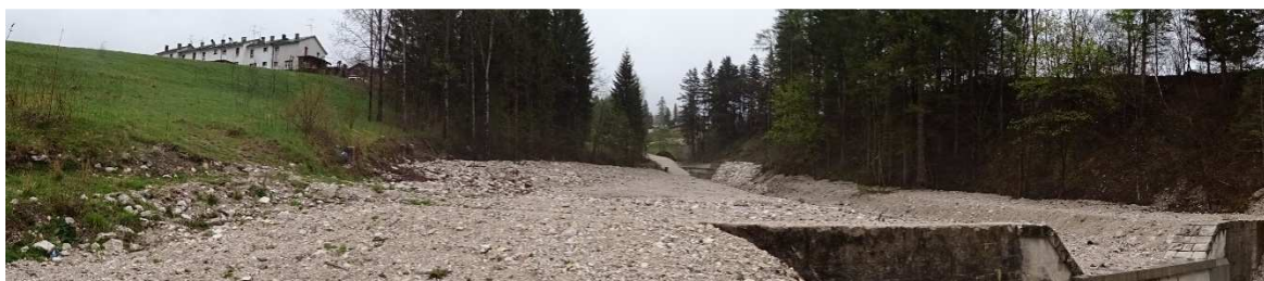
FOTO 7 – Il Ru Sec in corrispondenza dell’attraversamento di progetto
