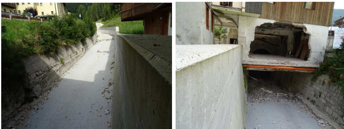
FOTO 3-4– Il Ru Sec nel tratto rivestito a monte del paese e la tombinatura lesionata a seguito degli eventi del 2015
