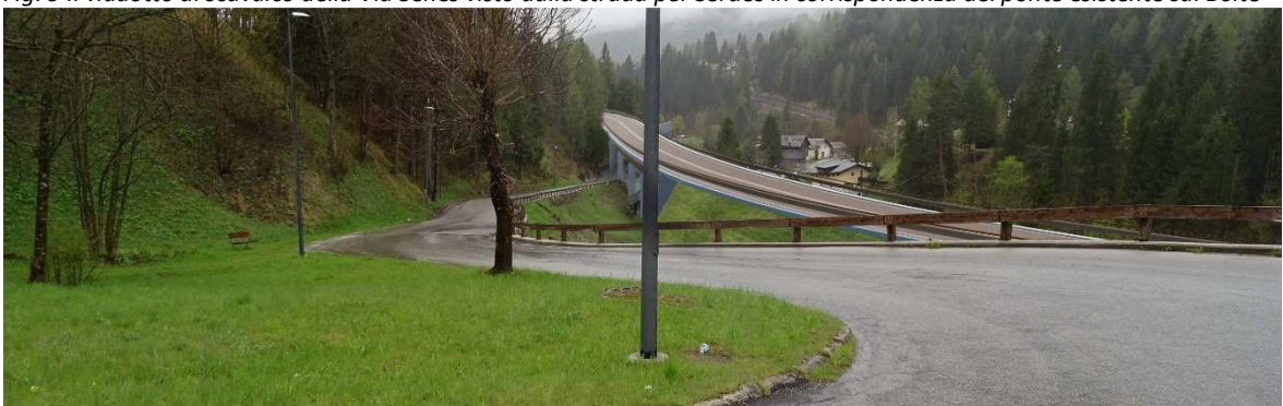
Fig. 10 Il viadotto Via Senes visto dal tornante di Via Serdes
