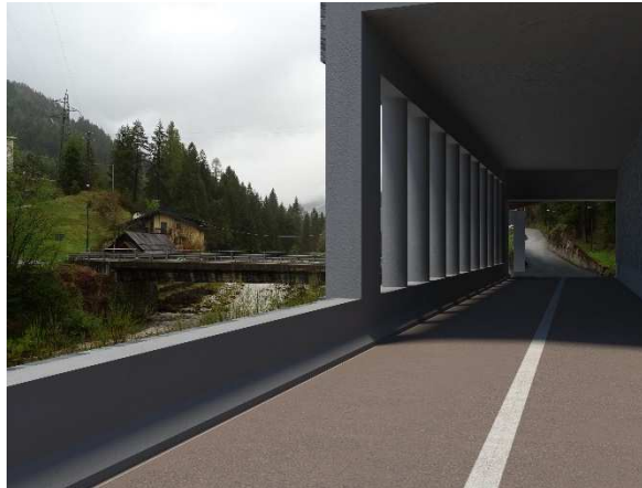
Fig. 11 Lo scatolare sfinestrato che funge anche da spalla del viadotto visto dall'interno di Via Senes visto
