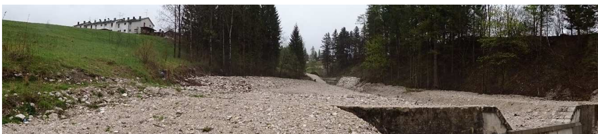
FOTO 5. Il Ru Sec in corrispondenza del ponte di progetto
