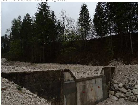
FOTO 7. Il sito della spalla in sinistra del ponte sul Rusecco
