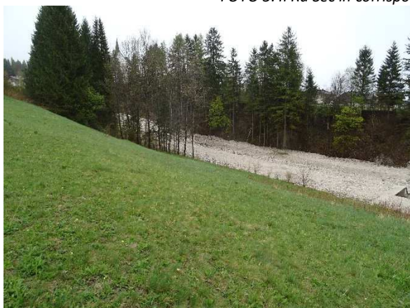
FOTO 6. Il sito della spalla in destra del ponte sul Rusecco
