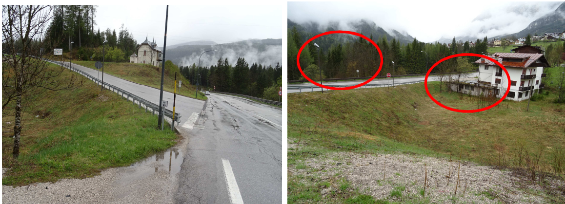
FOTO 1 e 2 L'immissione della rampa della zona artigianale nella SS51 (cerchiato il fabbricato interferente e il bosco)
