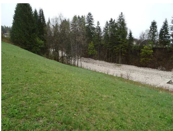
FOTO 9. Il sito della spalla in destra del ponte sul Rusecco
