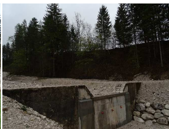
FOTO 10. Il sito della spalla in sinistra del ponte sul Rusecco
