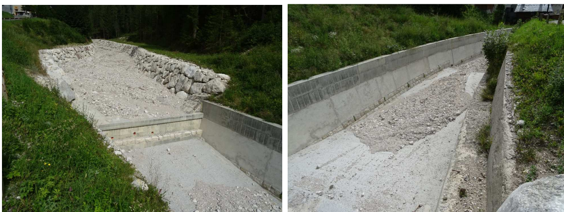
FOTO 1-2– Il Ru Sec a monte dell'abitato con i recenti interventi
