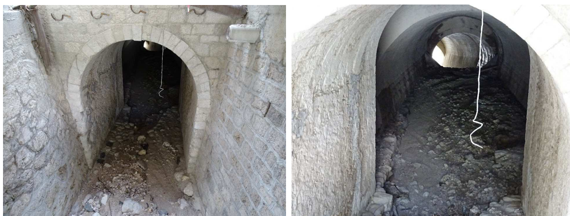
FOTO 5-6– La tombinatura del Ru Sec sotto il paese con i resti del trasporto solido
