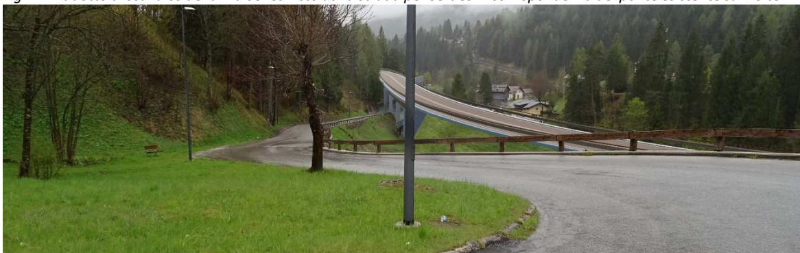
Fig. 5 Il viadotto Via Senes visto dal tornante di Via Serdes
