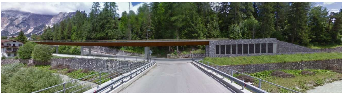
Fig. 4 Il viadotto di scavalco della Via Senes visto dalla strada per Serdes in corrispondenza del ponte esistente sul Boite
