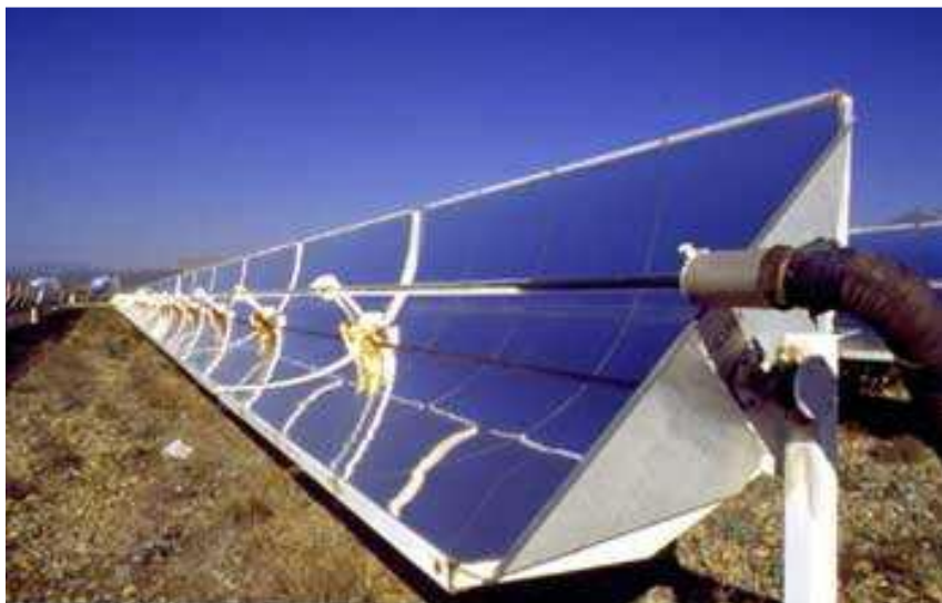
Figura 4 - Parabolic Trough, foto del collettore.
