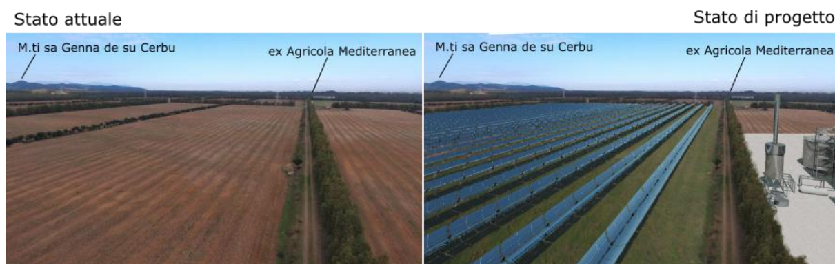
Figura 38 – Rendering fotorealistico dell'impianto in progetto, nelle prime fasi della sua vita utile.
