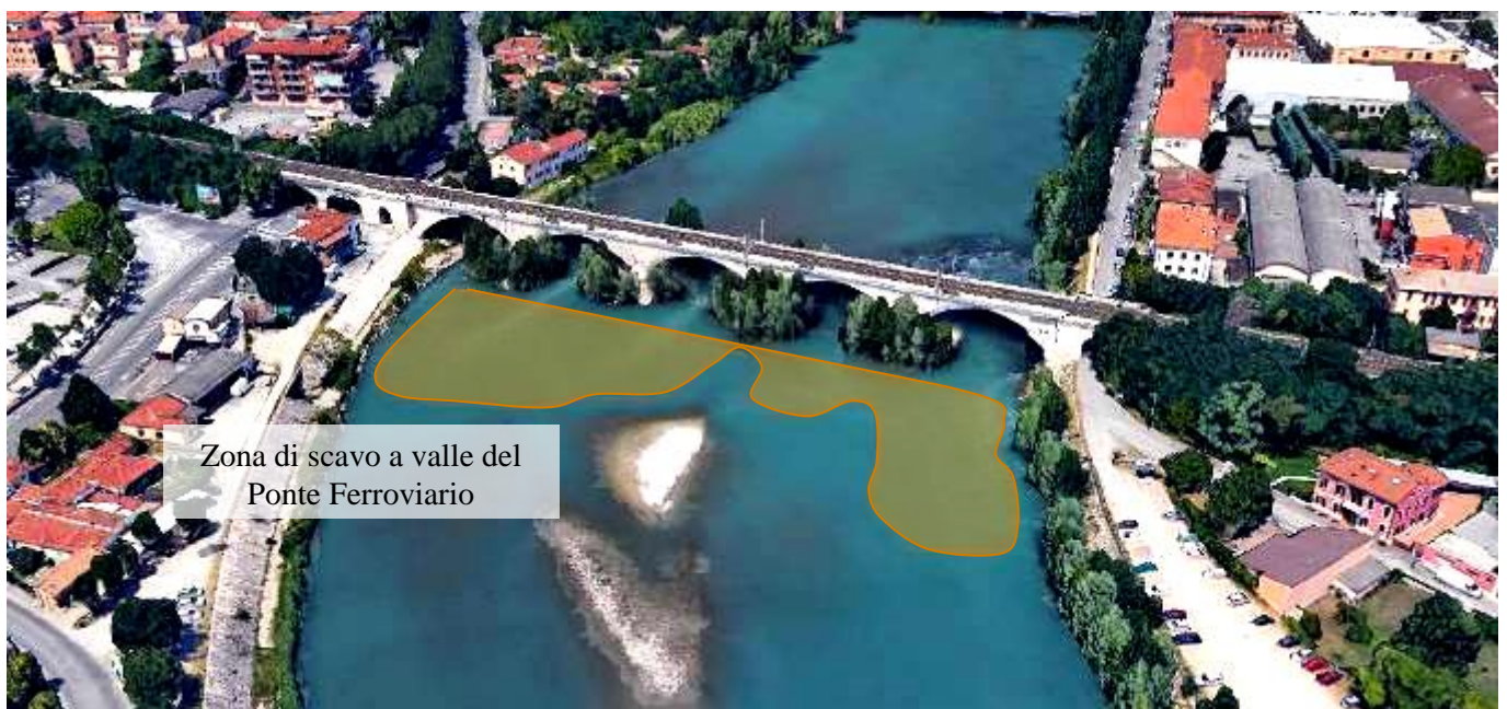
Figura 7: Zona di scavo a valle del Ponte Ferroviario.
