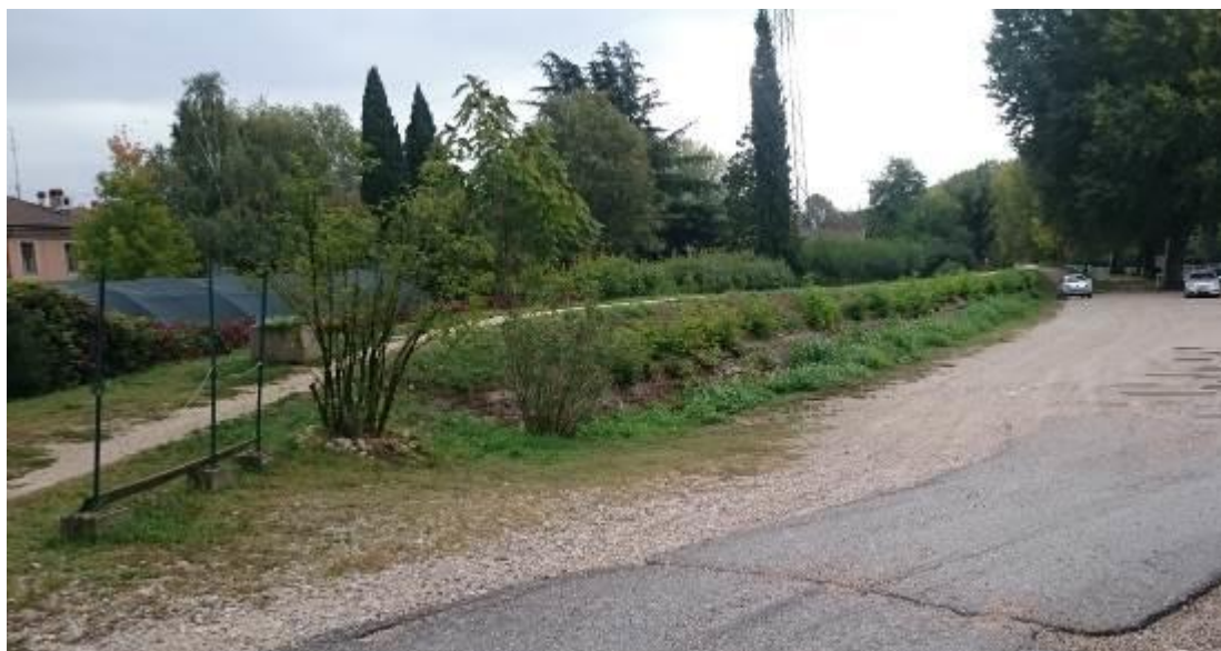
Figura 9: Argine di recente realizzazione in sinistra idraulica (2013).
