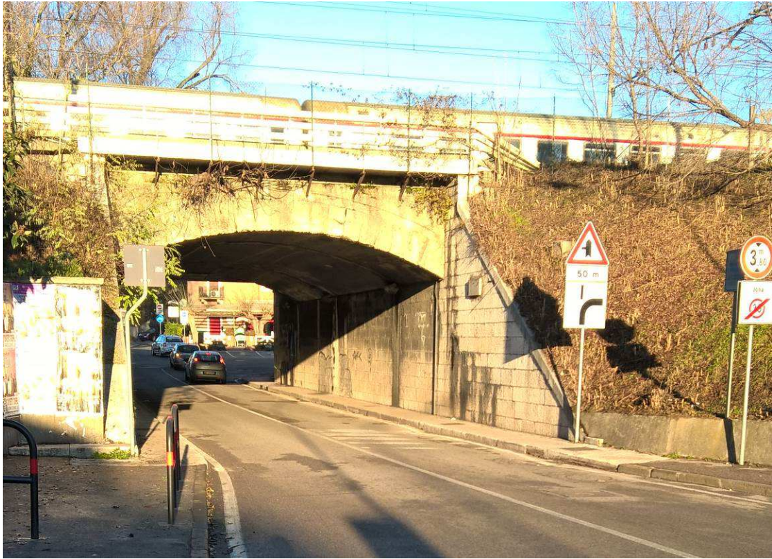
Immagine 10 Attraversamento di Via Ligabò –Vista Sud, lungo la via.
