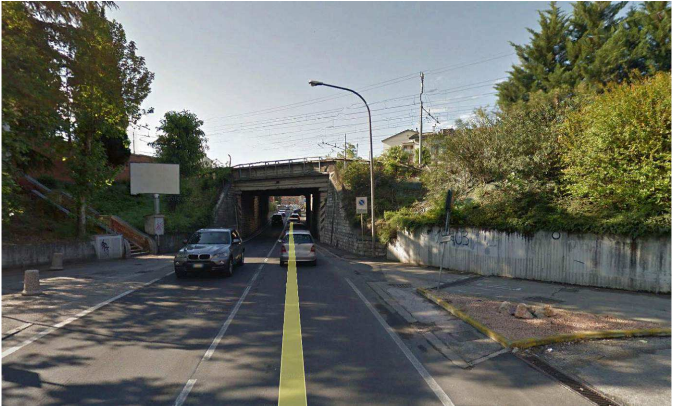
Immagine 3 Attraversamento di Via Albere Sud –Vista da Nord, lungo la via.
