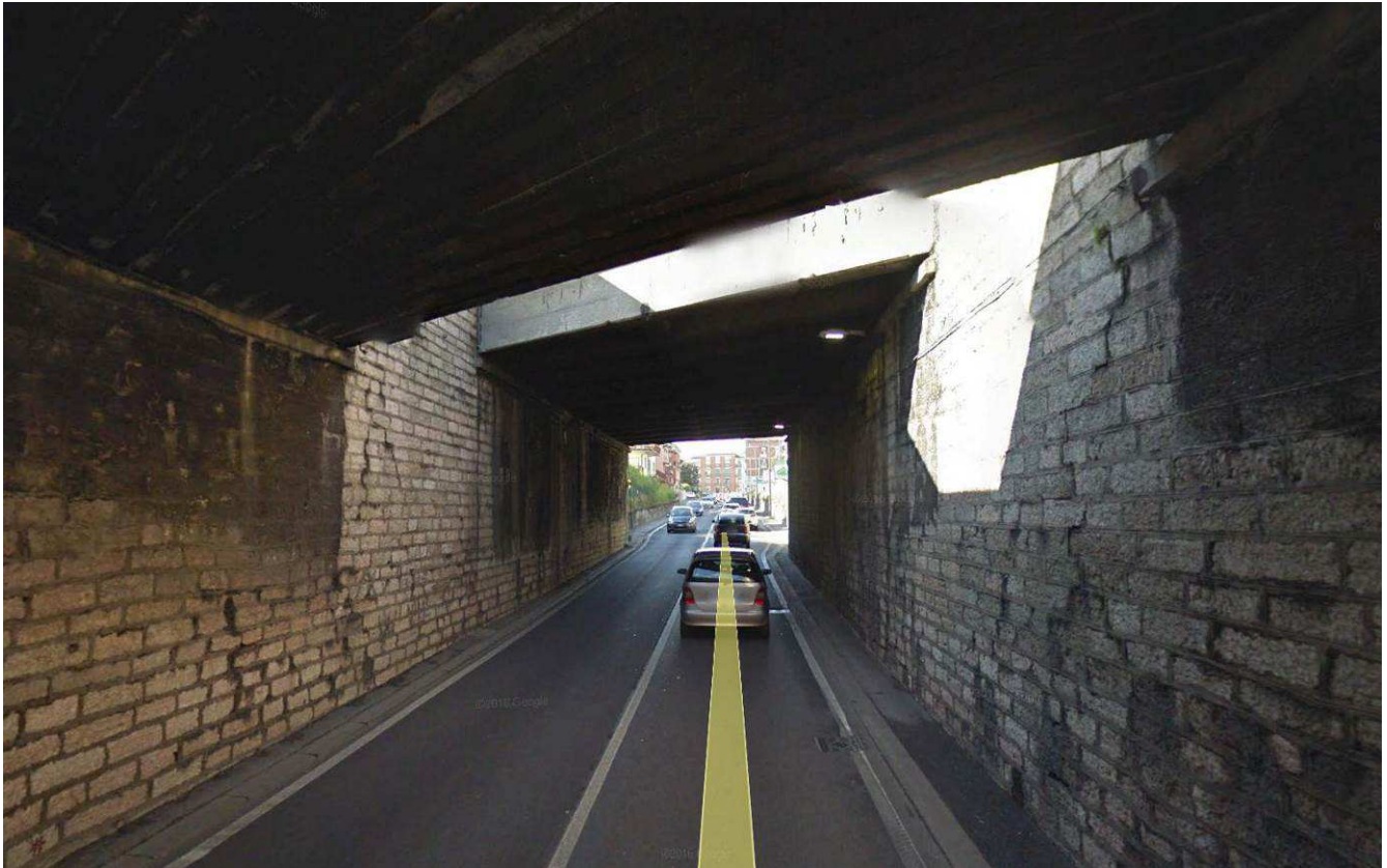
Immagine 4 Attraversamento di Via Albere Sud –Vista da Nord, all’interno del sottopasso.
