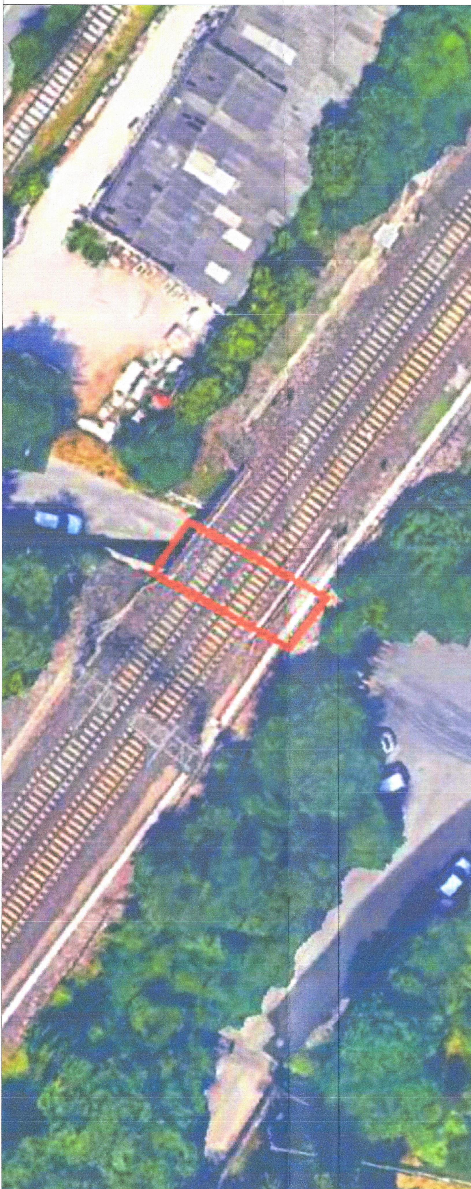
FOTO AEREA stato attuale
