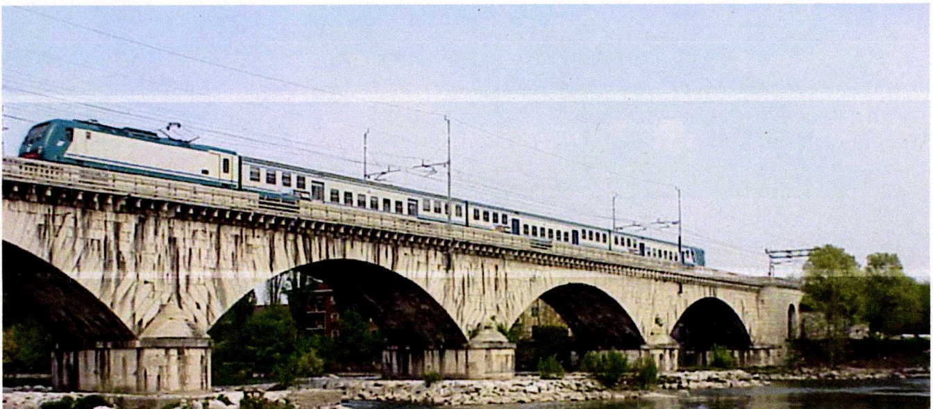
Figura 1 - Viadotto sul fiume Adige – Linea storica Campate centrali di luce 29 m - Punto di presa a sud del viadotto
