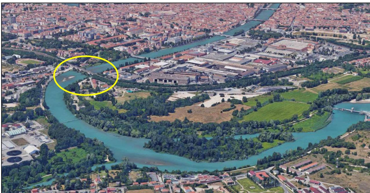
Figura 14-4 Fiume Adige, nel riquadro giallo è il punto in cui il nuovo viadotto ferroviario, parallelo e limitrofo all'esistente, attraversa il fiume. (Vista 3D di Google Maps)
