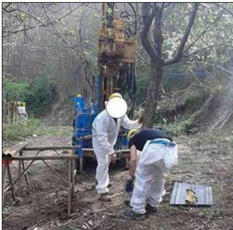
Figura 12: Sondaggio effettuato mediante perforazione a carotaggio.
