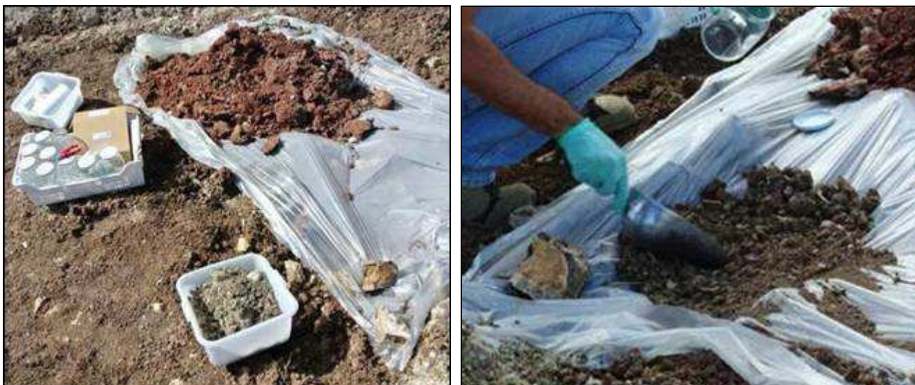
Figura 14: Deposito materiale scavato e Campionamento terre
