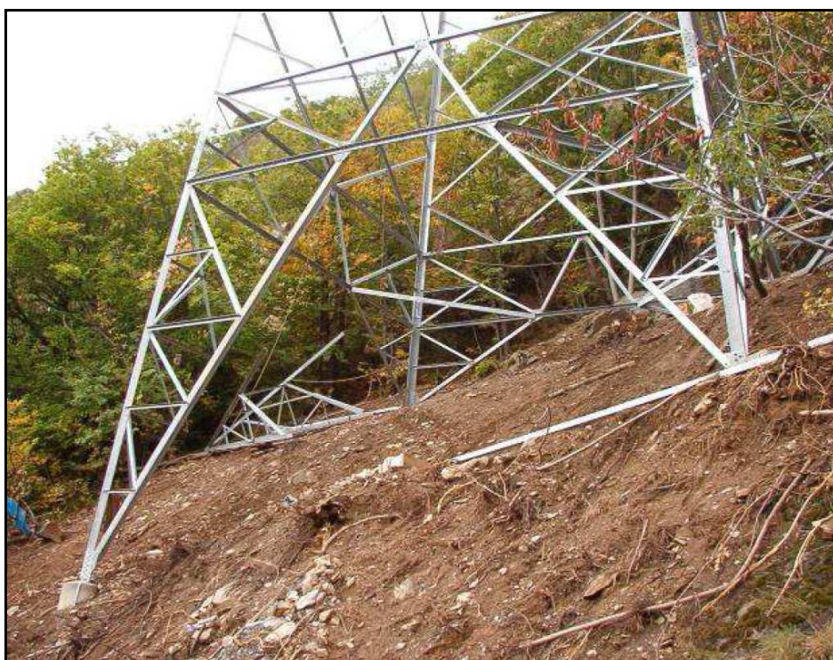
Figura 5: Zoppicature di un sostegno adattate al terreno
