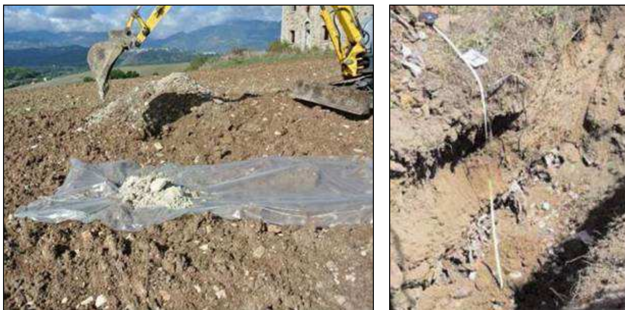
Figura 10: Scavo realizzato con pala meccanica. Consente di osservare la sequenza litologica sulle pareti dello scavo stesso e di verificare la presenza di una falda superficiale.
