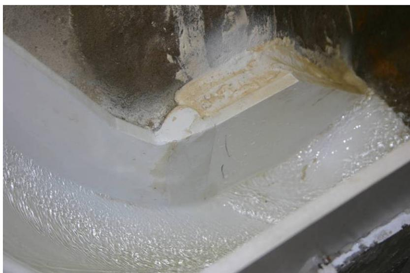
Figura 67 - Pelo libero sulla parte di valle del muro di sinistra
