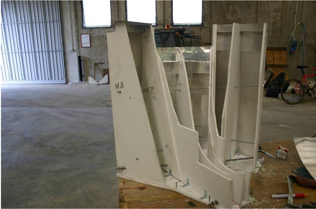
Figura 20 – Modine assemblate e casserete per la realizzazione della diga
