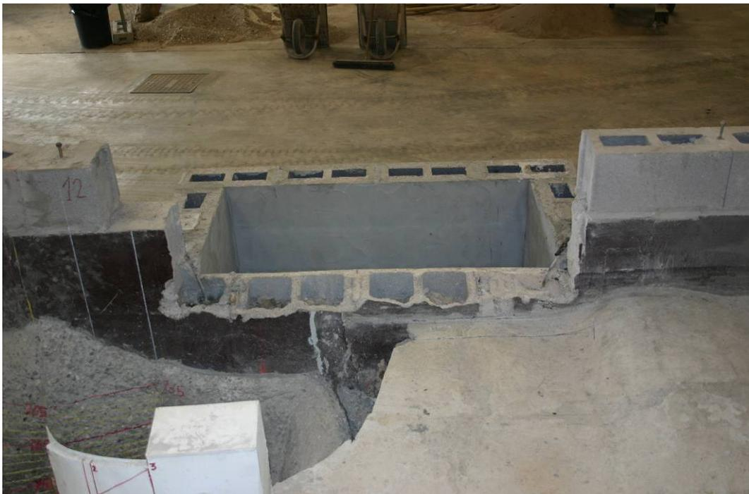
Figura 17 - Allargamento del perimetro della precedente vasca di contenimento del modello
