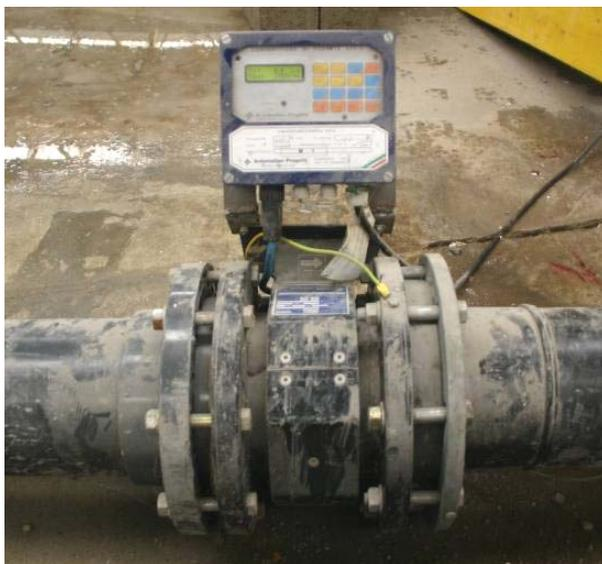
Figura 27 – Misuratore elettromagnetico di portata.
