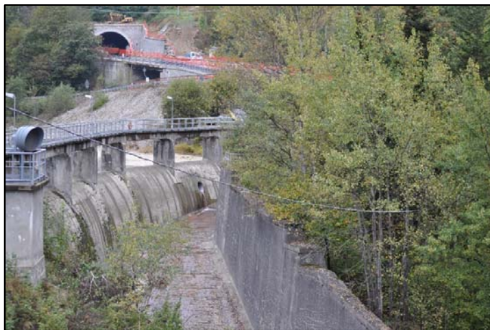
Figura 3.1d Vista dello scarico di superficie della Diga
