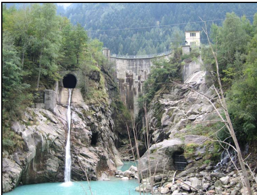
Figura 4.2.8.2f Foto 5 – La diga
