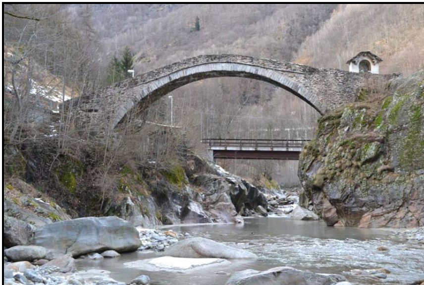
Figura 4.2.8.2e Foto 4 – Ceppo Morelli: il ponte Prea
