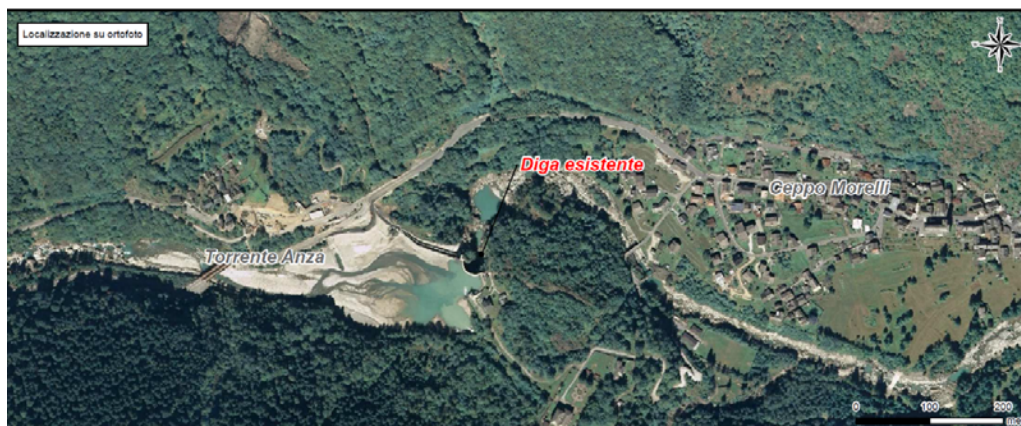
Figura 4.2.4.5a Localizzazione della Diga su ortofoto
