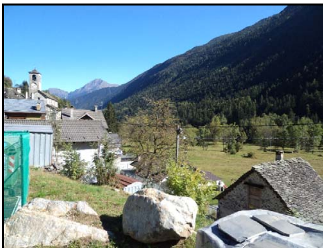
Figura 4.2.8.2d Foto 3 – Ceppo Morelli: il piano verso il torrente
