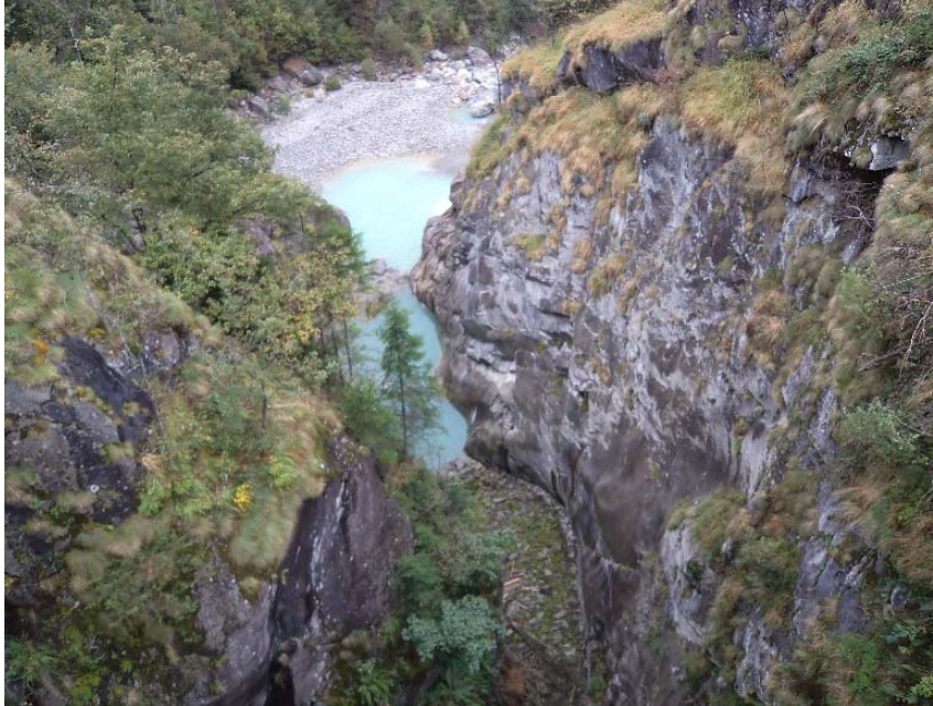
Figura 4.2.8.2g Foto 6 – La forra a valle della diga
