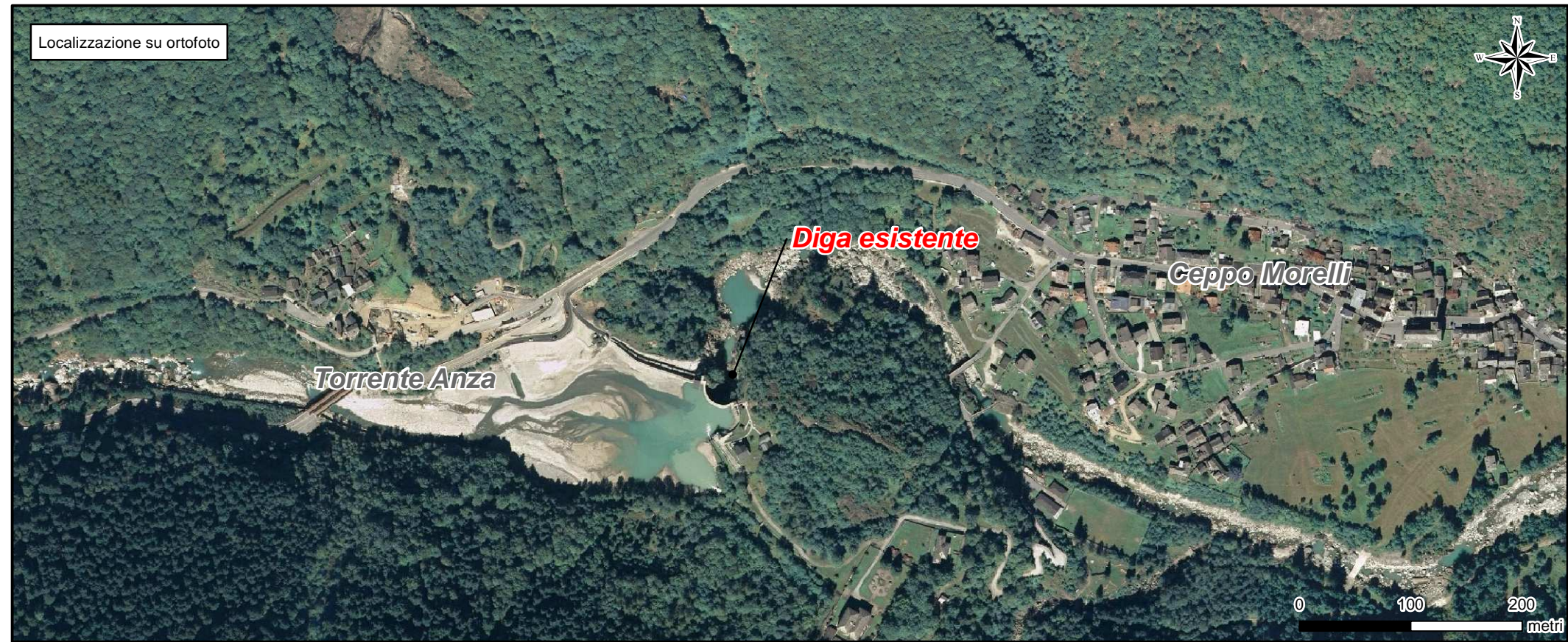
Figura 3.1a Localizzazione della Diga di Ceppo Morelli e delle Aree di cantiere
