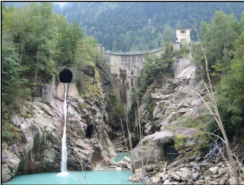
Figura 2.2.2f Foto 5 – La diga
