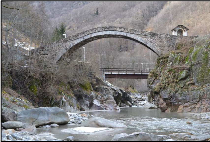
Figura 2.2.2e Foto 4 – Ceppo Morelli: il ponte Prea
