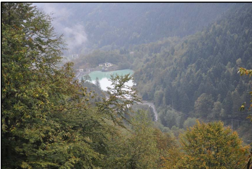
Figura 2.2.2h Foto 7 – Il serbatoio
