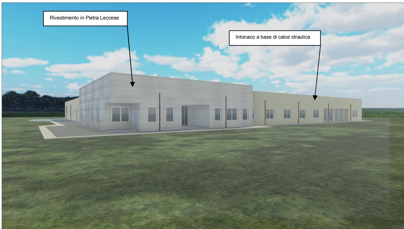
Fig. 3: Edificio Principale – Vista Nord-Est
