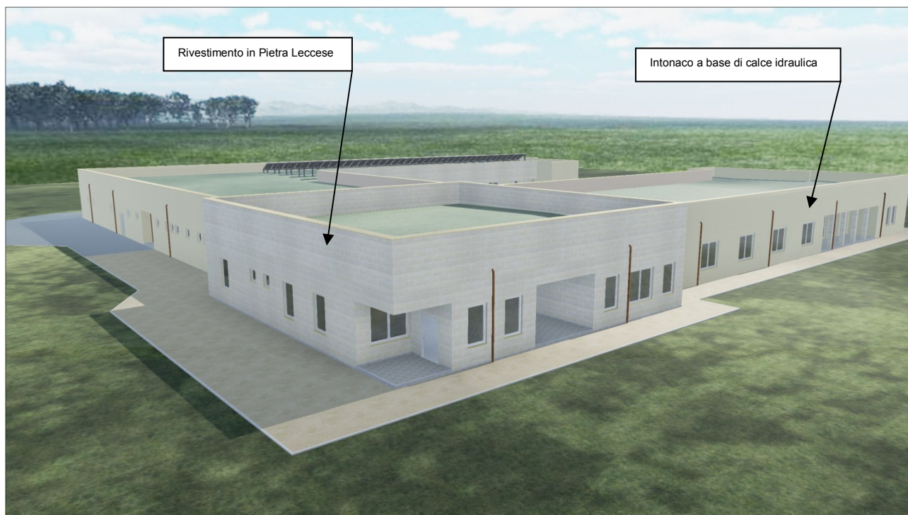
Fig. 2: Edificio Principale – Vista Nord-Est
