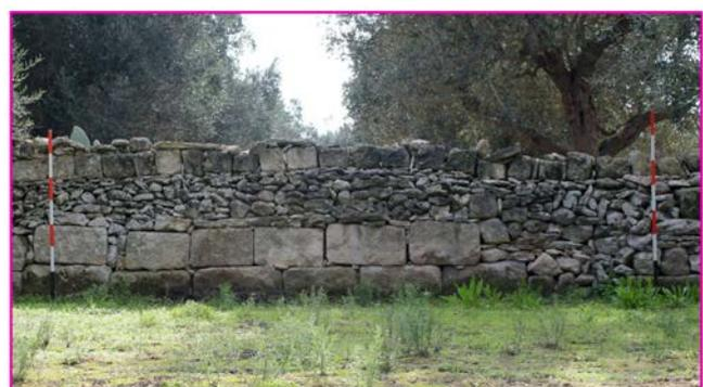
Tipo 6: Accumulazione a stratificazione con blocchi quadrati inseriti
