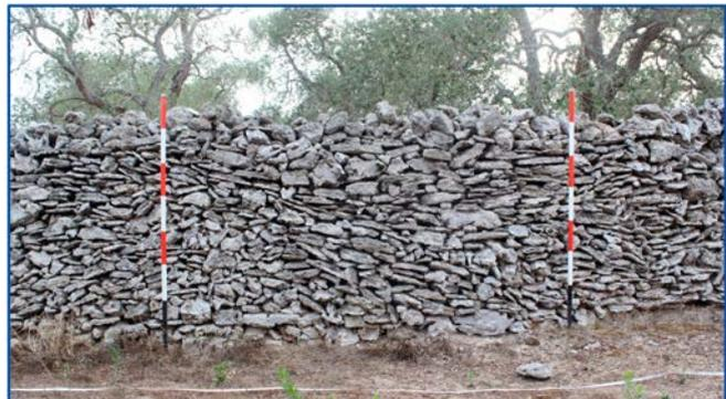
Tipo 4: Accumulazione a stratificazione con prevalenza di lastre
