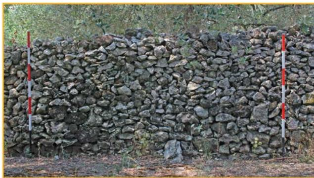
Tipo 3: Accumulazione a stratificazione con tessitura mediamente disordinata
