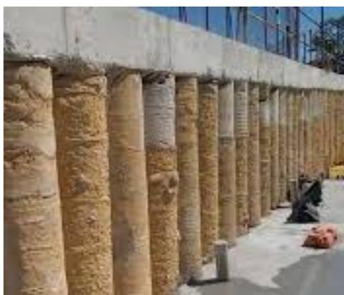
**Figura 21 – Esempio di trave di coronamento rigida**
