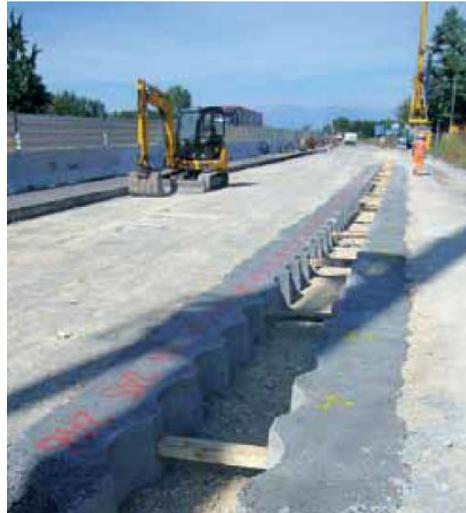
**Figura 12 – Esempio di cordolo guida per pali secanti**
