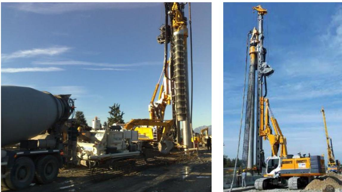
**Figura 16 – Getto del palo (a sinistra) e installazione dell'armatura (a destra)**
