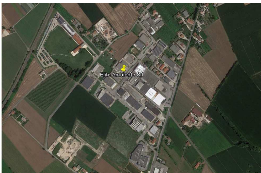
Figura 4-7: Impianto di recupero della ditta Elite Ambiente Srl, comune di Brendola (VI)
