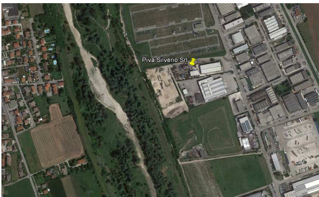
Figura 4-12: Impianto di trattamento e recupero della ditta Piva Silverio Srl, Comune di Sandrigo (VI)
