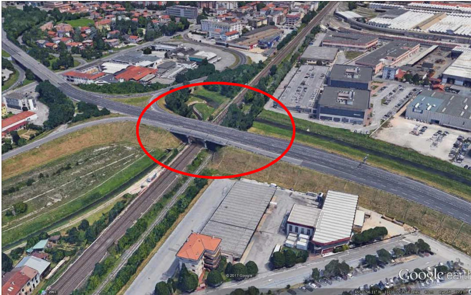
Figura 3-6 Vista aerea del Cavalcaferrovia Scaligeri esistente (da google earth)
