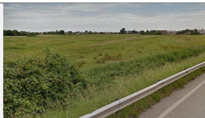
Figura 4-14 Vista da Viale Camisano in direzione dell'area agricola interessata dalla realizzazione del nuovo asse stradale NV12 e del cavalferrovia IV05 (fonte: Google Maps)
