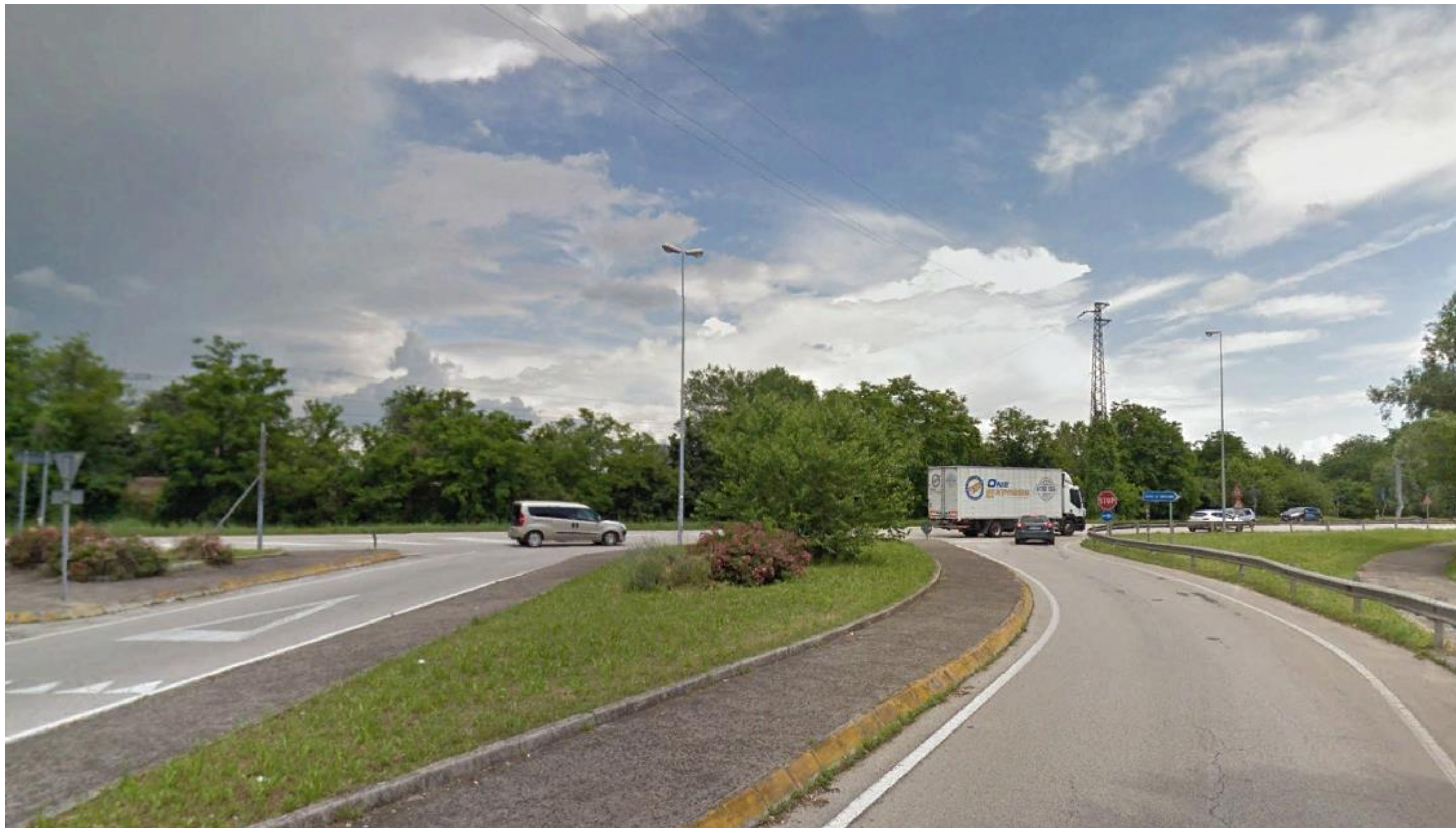
Figura 67 Vista da Via Vicenza in direzione dell'intervento, in cui saranno visibili le barriere antirumore e gli interventi della NV01 (fonte: Google Earth)
