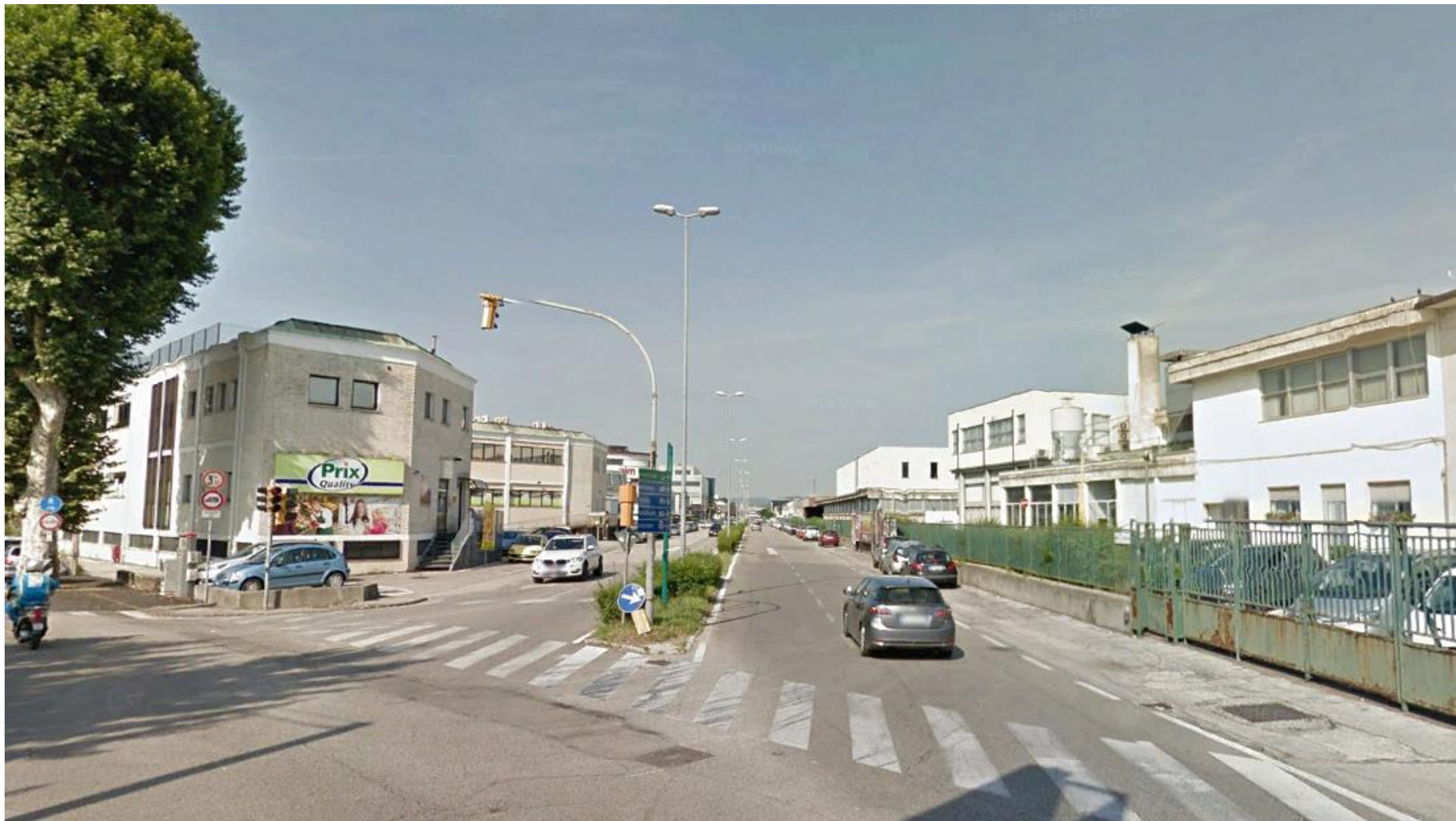
Figura 82 Vista da Viale Industria, ravvicinata e diretta, in direzione dell'intervento della nuova viabilità NV7 (fonte: Google Earth)
