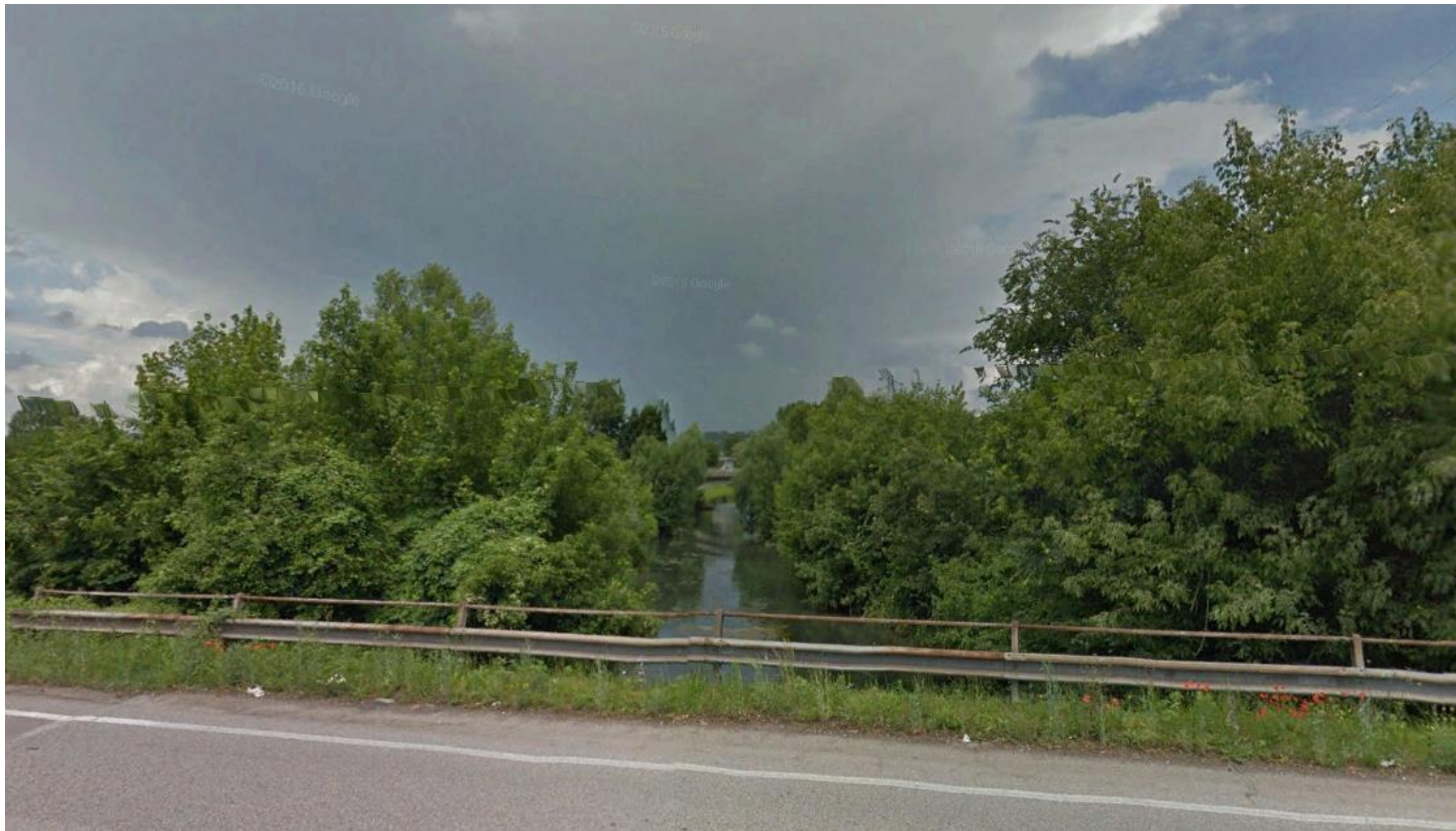
Figura 68 Vista da Viale della Scienza ravvicinata, ma filtrata dalla presenza della vegetazione, in direzione dell'intervento in rimarrà visibile il Ponte Retrone, con alle spalle la barriera antirumore (fonte: Google Earth)
