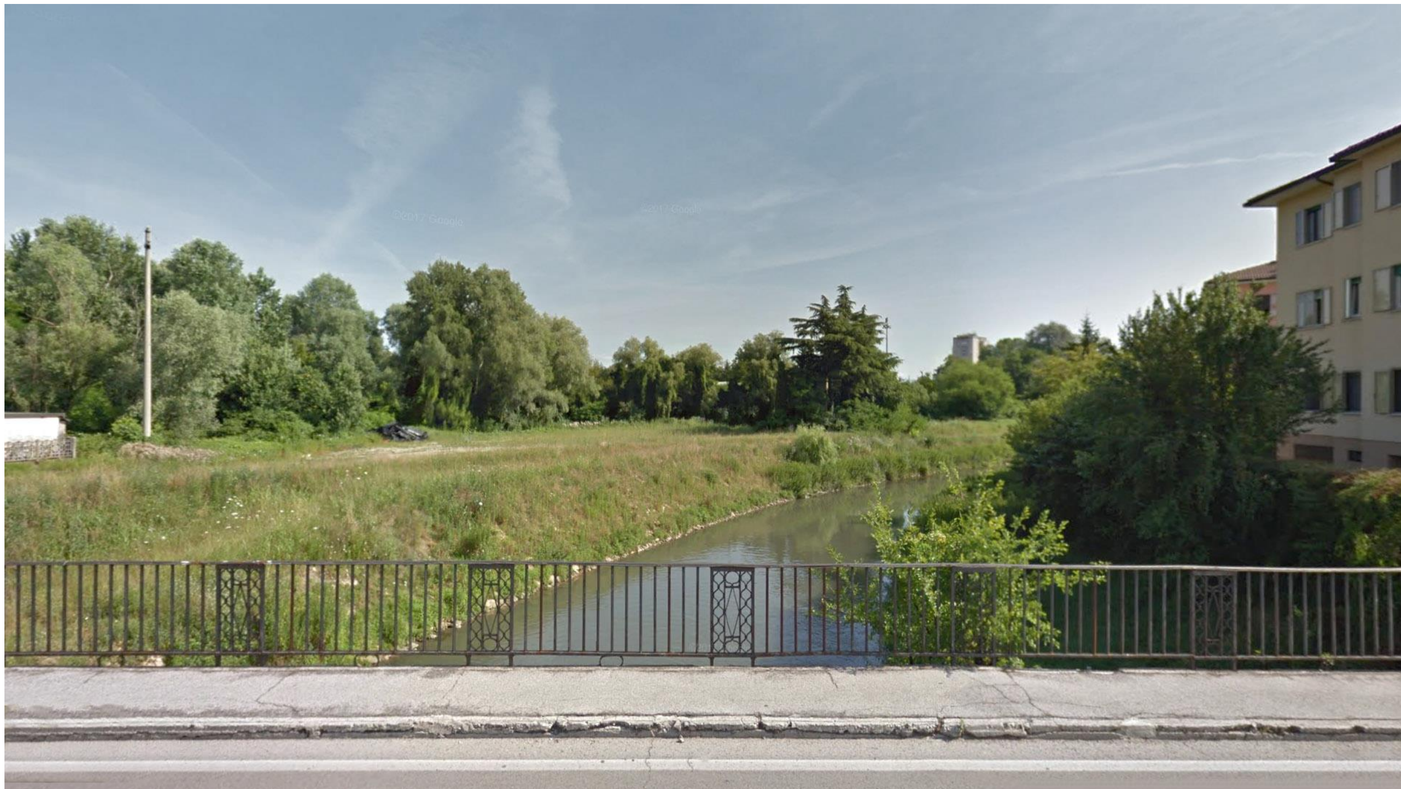
Figura 83 Vista da Via G. Maganza, sul fiume Retrone in direzione del cavalcavia IV04 di progetto, ravvicinata ma condizionata dalla presenza della vegetazione (fonte: Google Earth)
