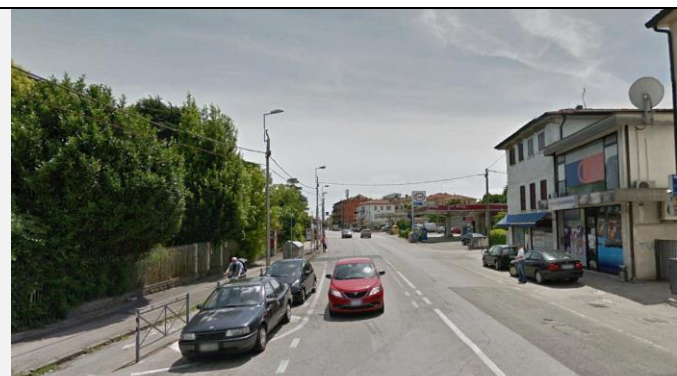
Figura 4-46 4-47 Vista di Viale della Pace, interessato dal percorso del nuovo filobus, in prossimità di dove verrà installata la fermata 13
