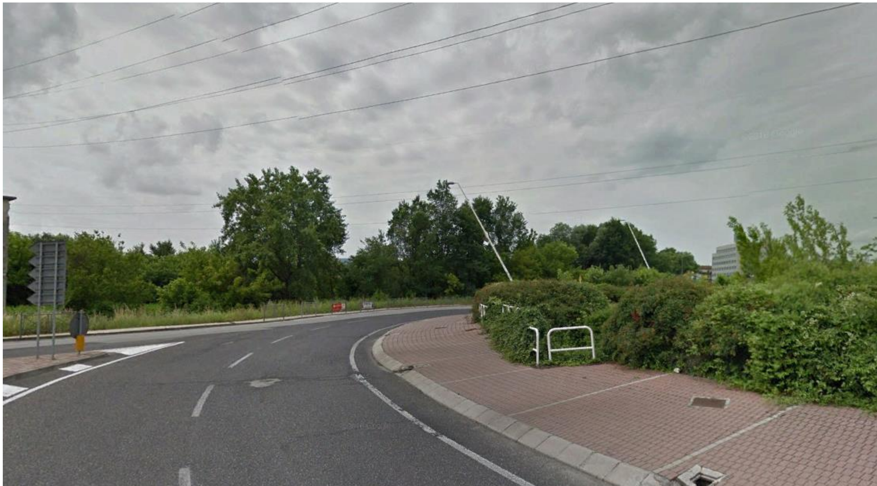
Figura 72 Vista dalla rotatoria della SR11, ravvicinata e diretta, in direzione dell'intervento della nuova viabilità NV02 (fonte: Google Earth)
