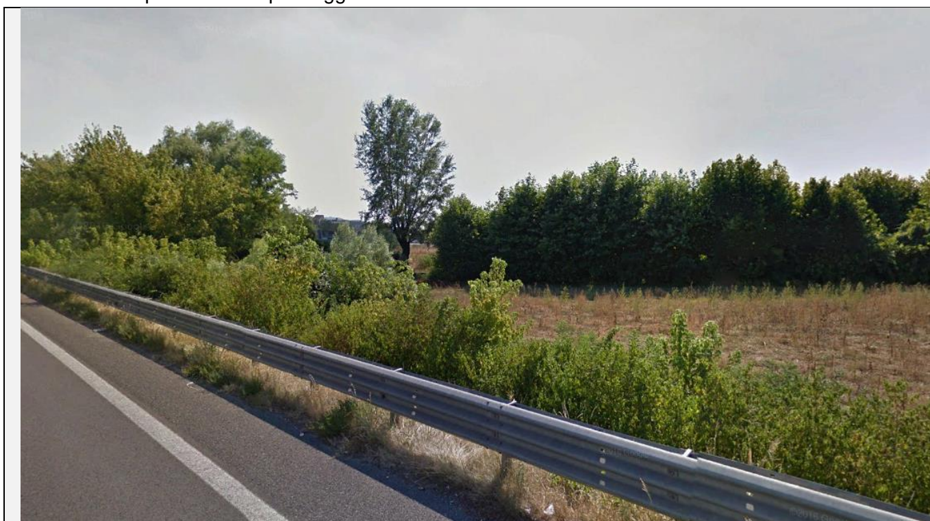
Figura 4-16 Vista da Viale del Sole in direzione dell'area rurale ambientale interessata dalla realizzazione della nuova viabilità NV05 (fonte: Google Maps)
