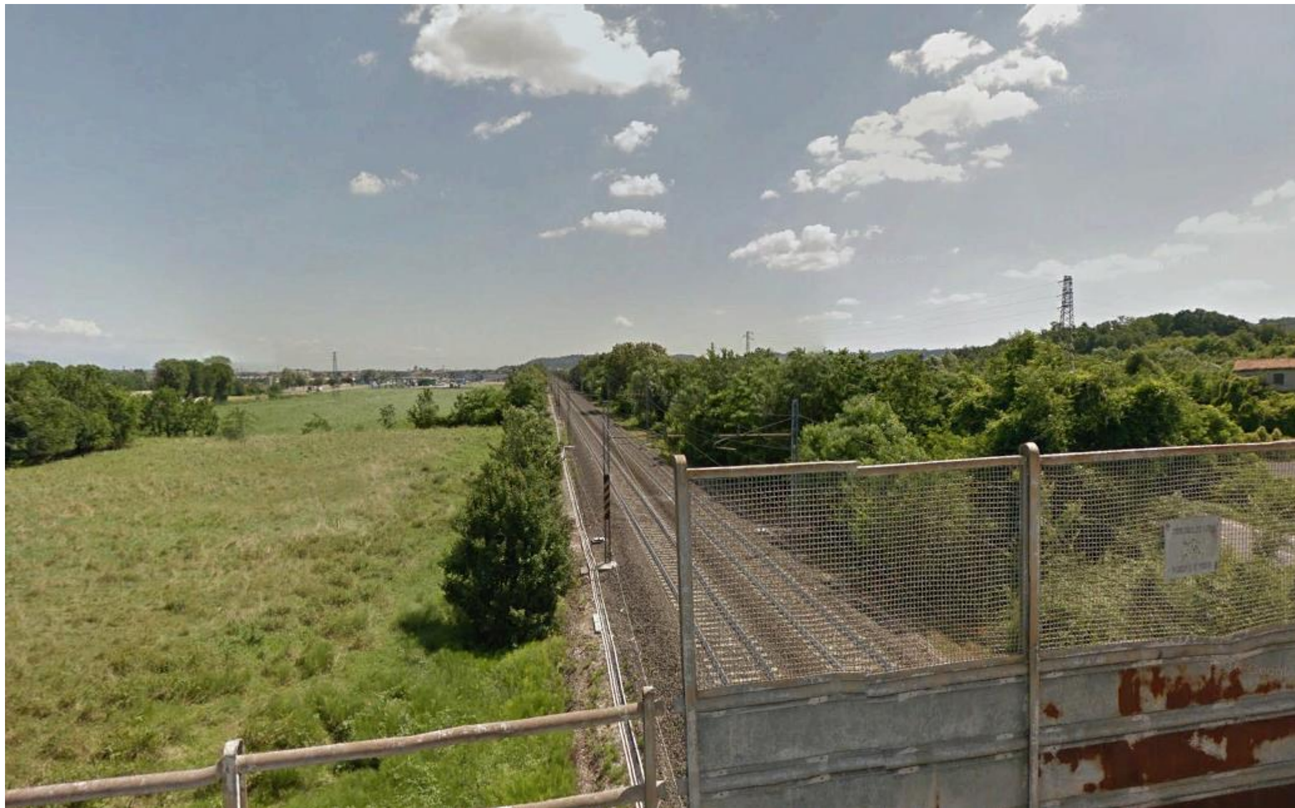
Figura 62 - Vista ravvicinata e diretta, in direzione del tratto di ferrovia in cui avrà inizio l'intervento della nuova Linea AV/AV, al Km 43+650, dal ponte ferroviario di Via N.Paganini (fonte: Google Earth)
