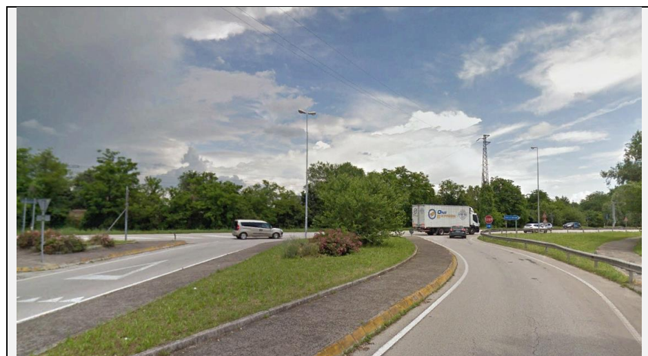
Figura 4-32 Vista da Via Vicenza in direzione dell'intervento, in cui saranno visibili le barriere antirumore e gli interventi della
