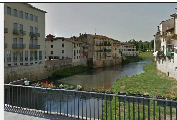
Figura 4-7 Vista dal Ponte degli Angeli, interessato dal nuovo percorso del filobus, verso il Fiume Retrone (fonte: Google Maps)
