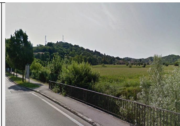
Figura 4-10 Vista da Via G. Maganza, interessato dall'intervento IV04, in direzione dell'area boscata del Monte Berico presente a sud dei fasci di binari, in prossimità della stazione ferroviaria di Vicenza (fonte: Google Maps)
