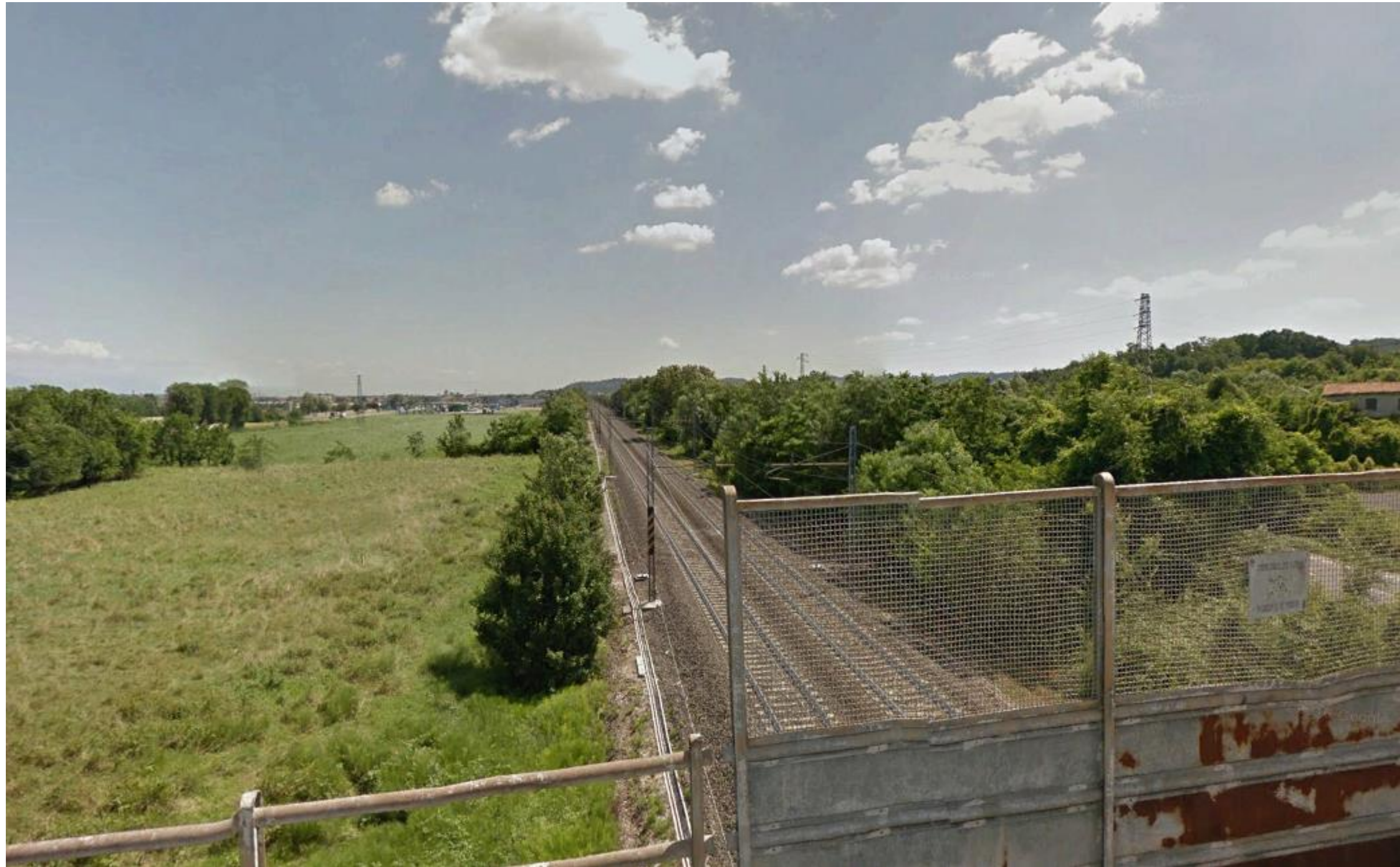
Figura 1 - Vista ravvicinata e diretta, in direzione del tratto di ferrovia in cui avrà inizio l'intervento della nuova Linea AV/AV, al Km 43+650, dal ponte ferroviario di Via N.Paganini (fonte: Google Earth)
