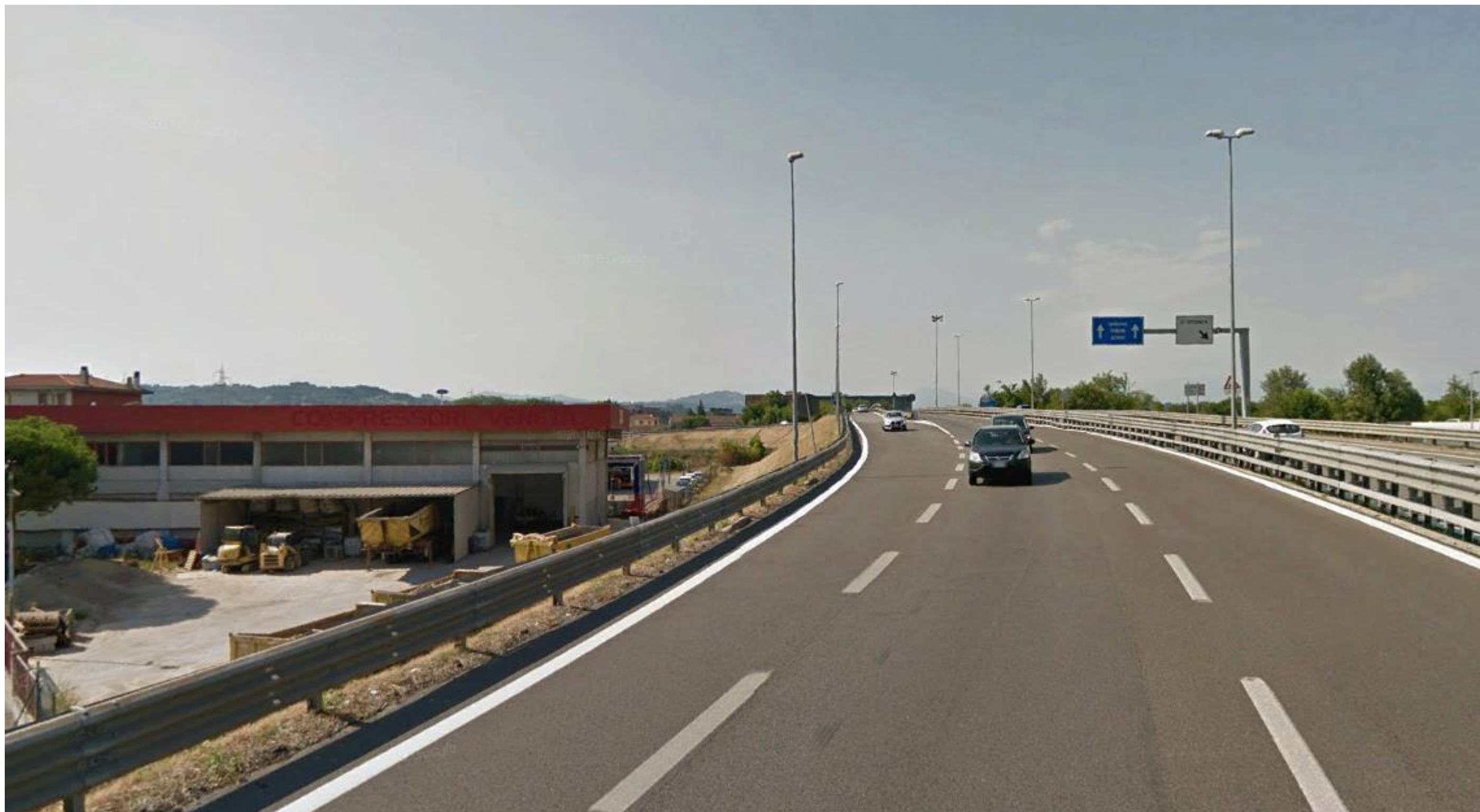
Figura 12 Vista da Viale degli scaligeri , ravvicinata e diretta, in direzione del calvalcaferrovia degli Scaligeri IV01B di progetto (fonte: Google Earth)
