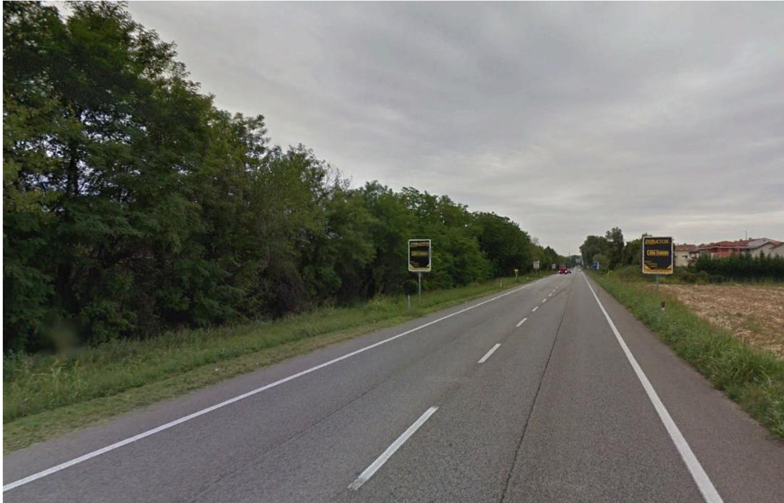
Figura 3 - Vista dalla SP34, ravvicinata e diretta, in direzione dell'intervento ferroviario, in cui non saranno però visibili le sole barriere antirumore (fonte: Google Earth)
