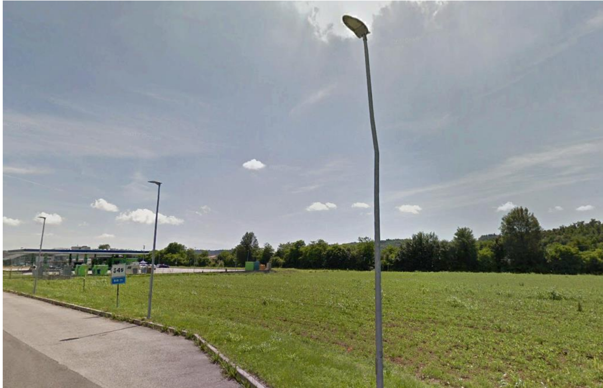
Figura 2 Vista dalla SR11, ravvicinata e diretta, in direzione dell'intervento ferroviario, in cui saranno però visibili le sole barriere antirumore (fonte: Google Earth)
