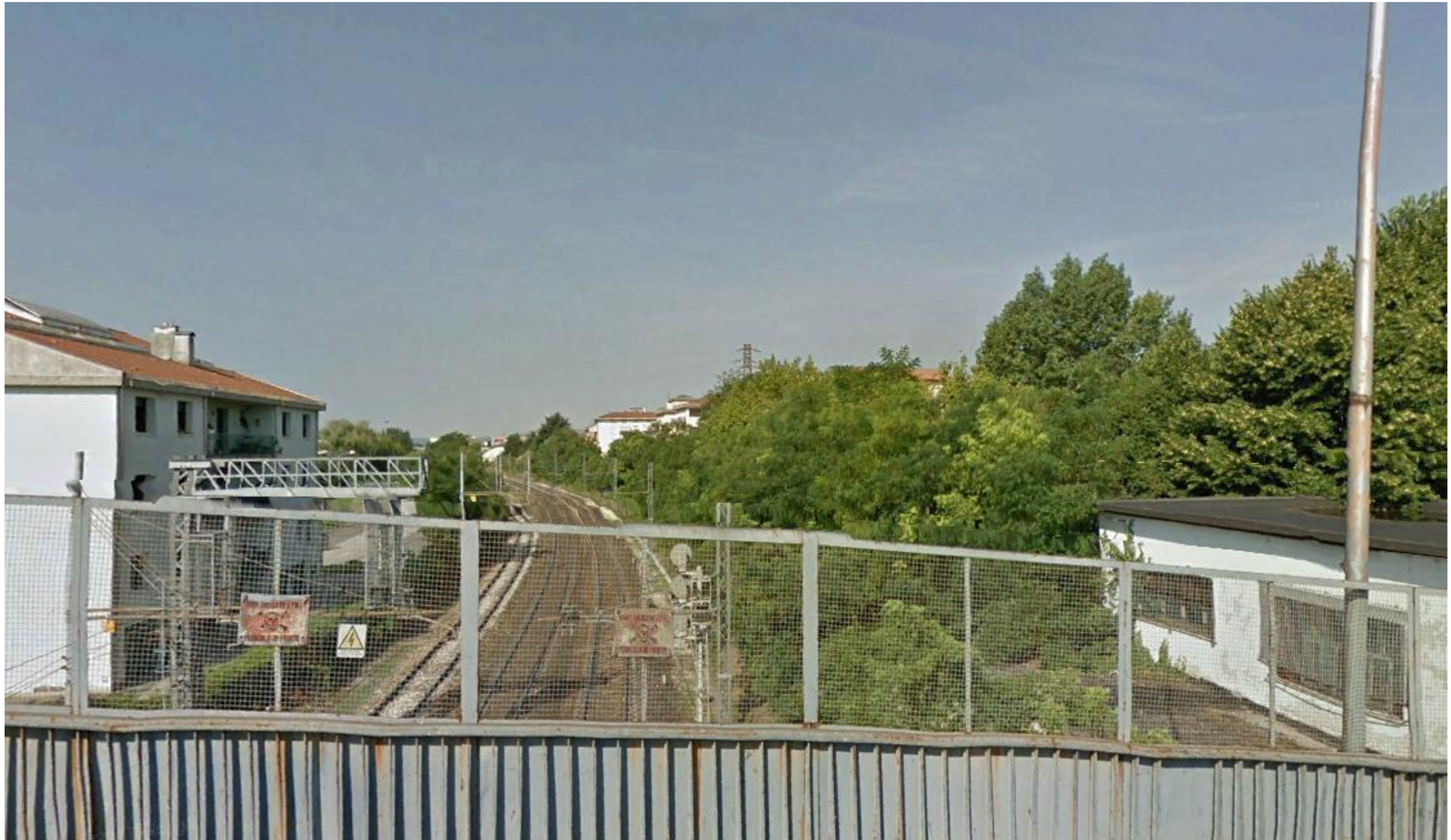
Figura 19 Ampia visuale sulla linea ferroviaria esistente, in direzione ovest, e oggetto di intervento dal ponte ferroviario di Via Ferretto da Ferretti (fonte: Google Earth)
