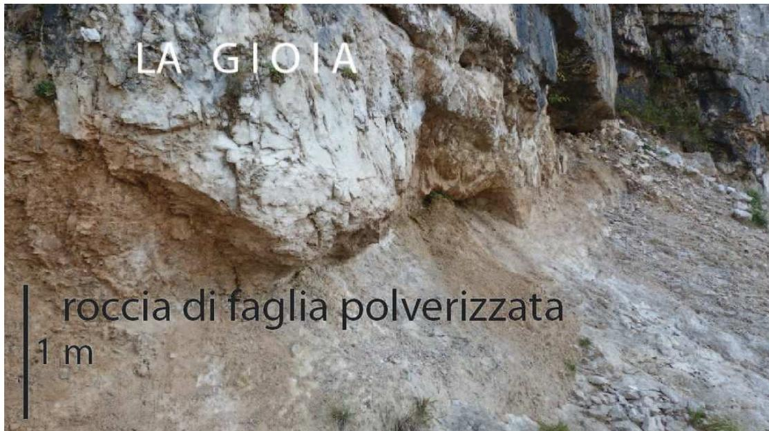
*Particolare della base parete La Gioia in cui si nota lo stato estremamente fratturato della roccia di faglia, verosimilmente caratterizzata da bassi valori di resistenza al taglio.*
