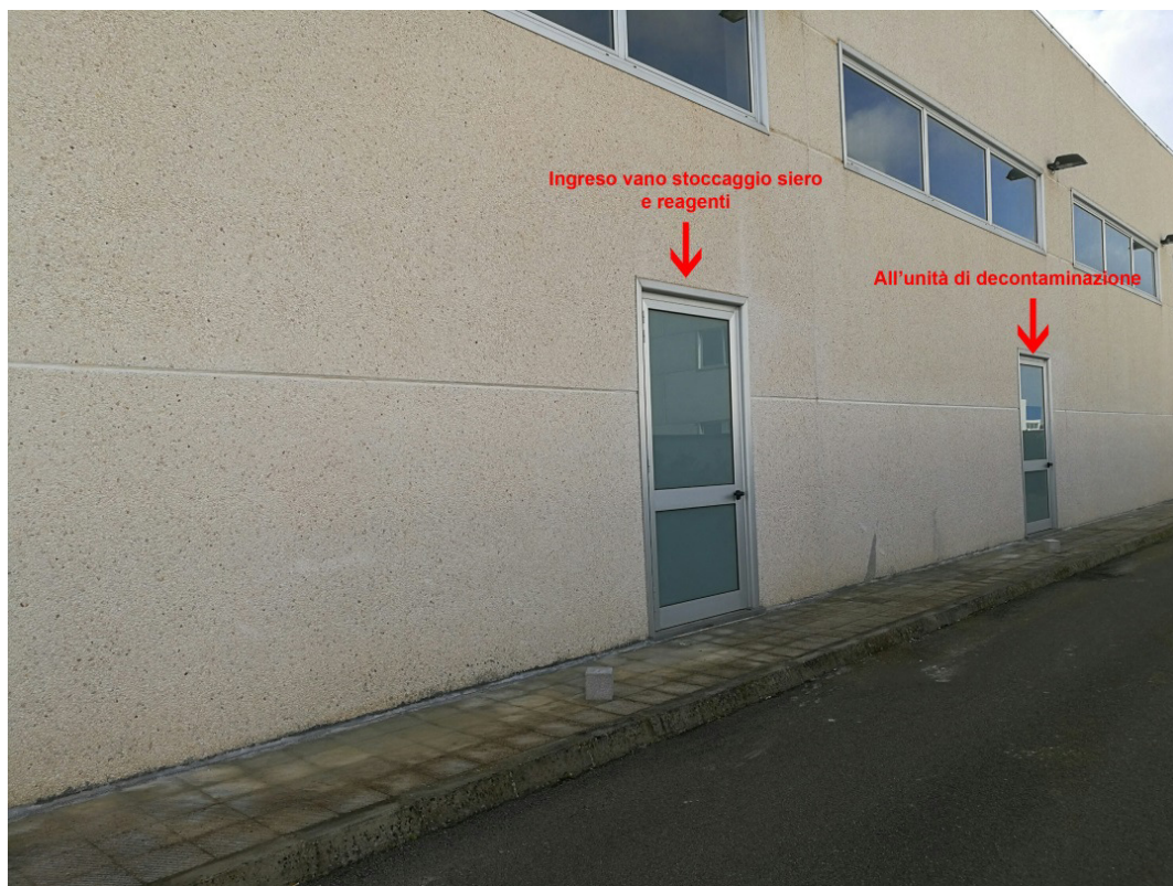
Figura 7 – Vista dall'esterno dell'ingresso locale trattamento MCA
