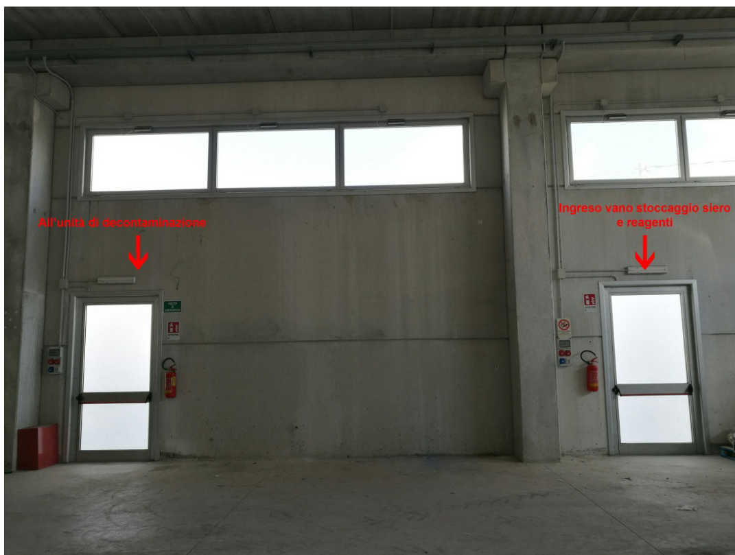
Figura 8 – Vista dall'interno dell'ingresso locale trattamento MCA
