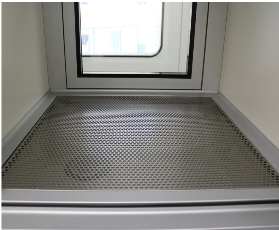
Fig. 3-a –Particolare griglia di aspirazione. Nella pagina successiva le relative specifiche dimensionali e costruttive.
