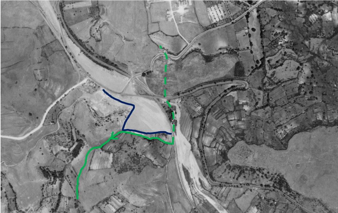
Foto 7 – Ortofoto dello Svincolo di Bonorva risalente al 1968, nel corso dei lavori di ammodernamento. Si nota l'importante rilevato realizzato a valle della linea FS (il cui piede è delimitato in blu) e il nuovo andamento del torrente (in verde).
