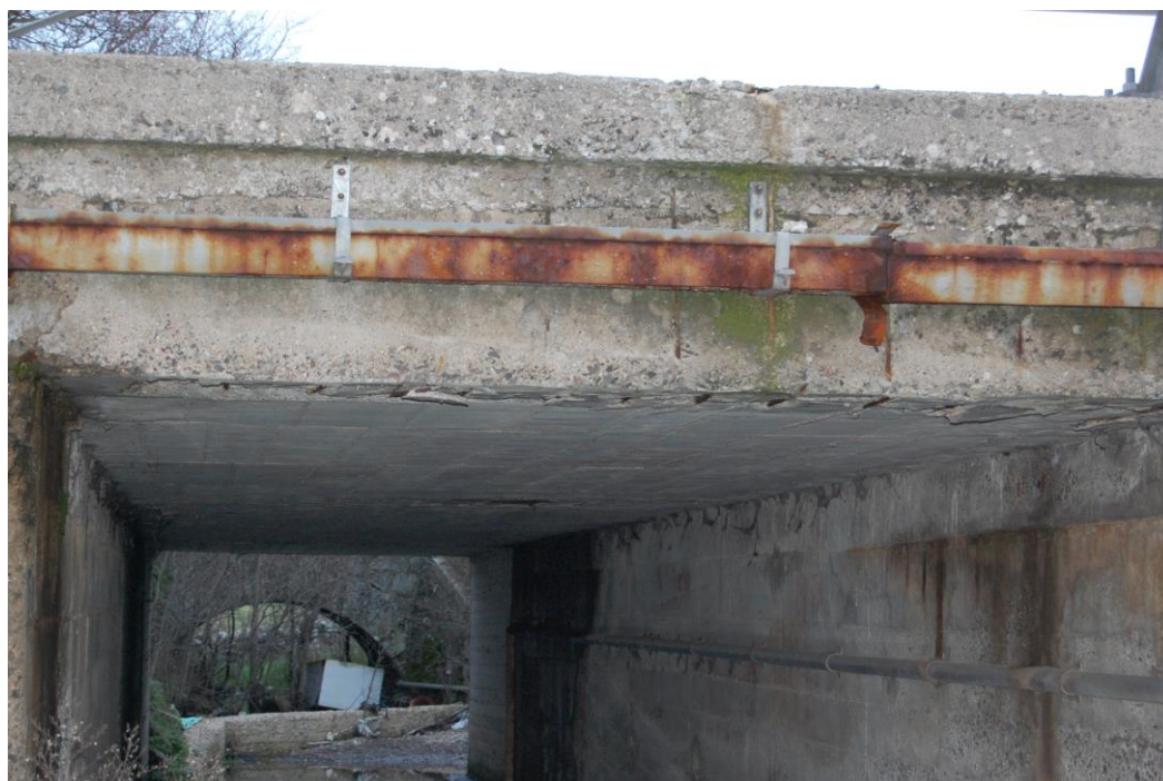
Foto 2 opera di attraversamento della attuale sede della SS 131 e della SP 125
