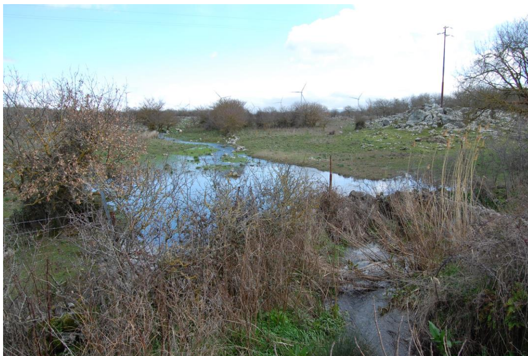
Foto 4 opera di attraversamento della attuale sede della SP 125 – Vista a monte
