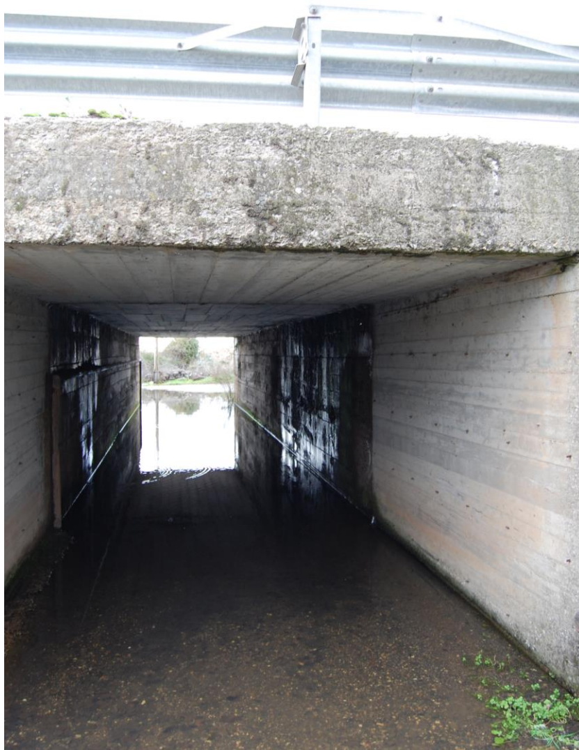
Foto 1 - opera di attraversamento della attuale sede della SS 131 Carlo Felice
