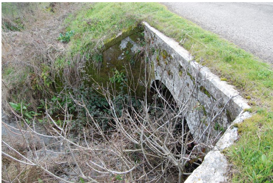
Foto 3 opera di attraversamento della attuale sede della SP 125 – Vista da valle
