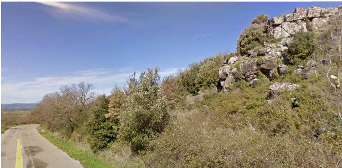
Figura 4: Vista dall'alto del tratto sud tra la pk 3+190-3+350 (il giallo indica il punto in cui sono state catturate le immagini con la vista del fronte roccioso potenzialmente instabile e dei massi erratici presenti nell'intorno della strada)
