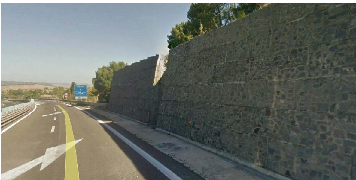
Figura 1: Vista del muro di contenimento esistente
