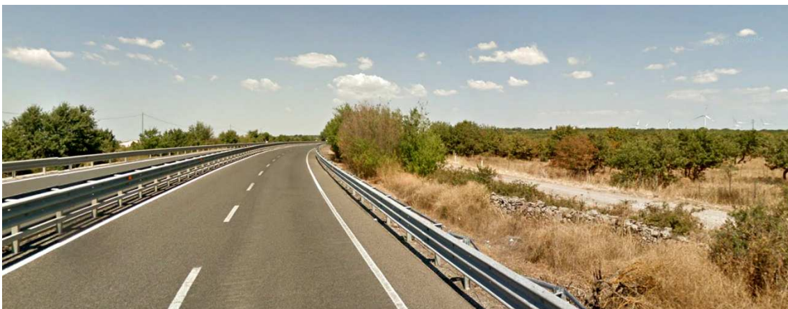
Figura 2-13 Punto di vista A1 lungo la SS 131 in prossimità dello svincolo Bonorva sud
