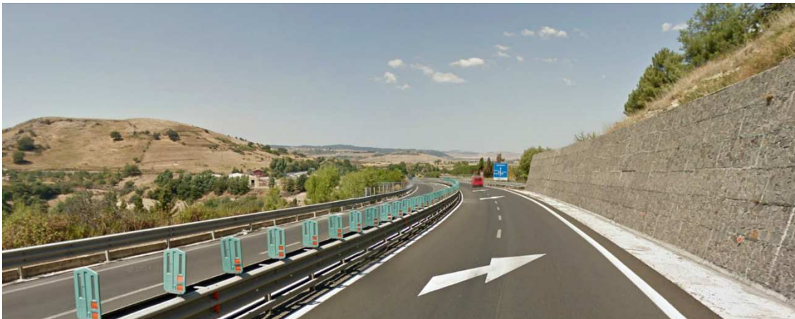
Figura 2-16 Punto di vista A1 lungo la SS 131 in prossimità dello svincolo Bonorva nord
