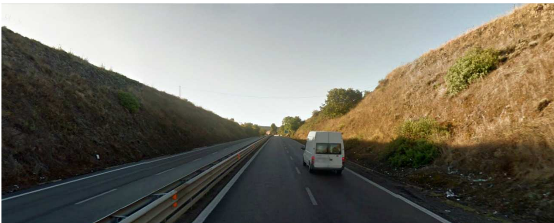
Figura 2-17 Punto di vista A2 lungo la SS 131 in prossimità dello svincolo Bonorva nord
