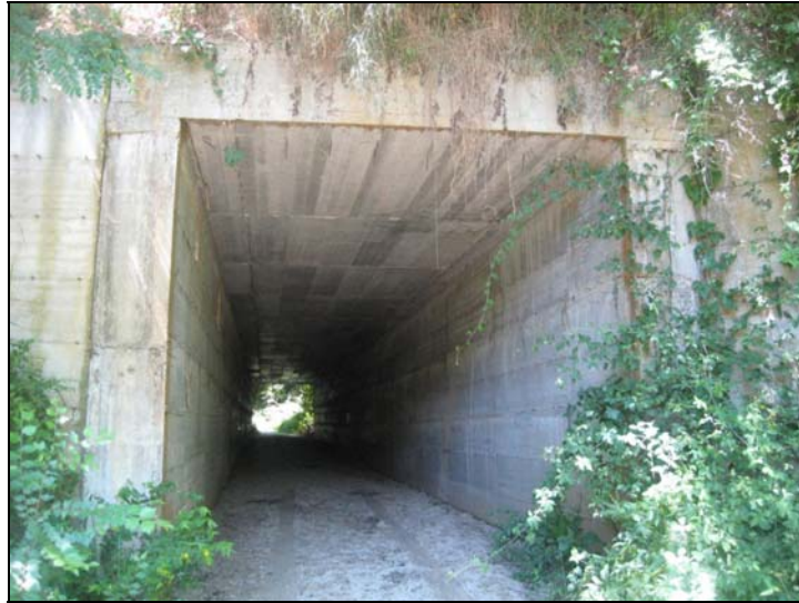
Imbocco e canna tombino esistente a pk 0+345.
