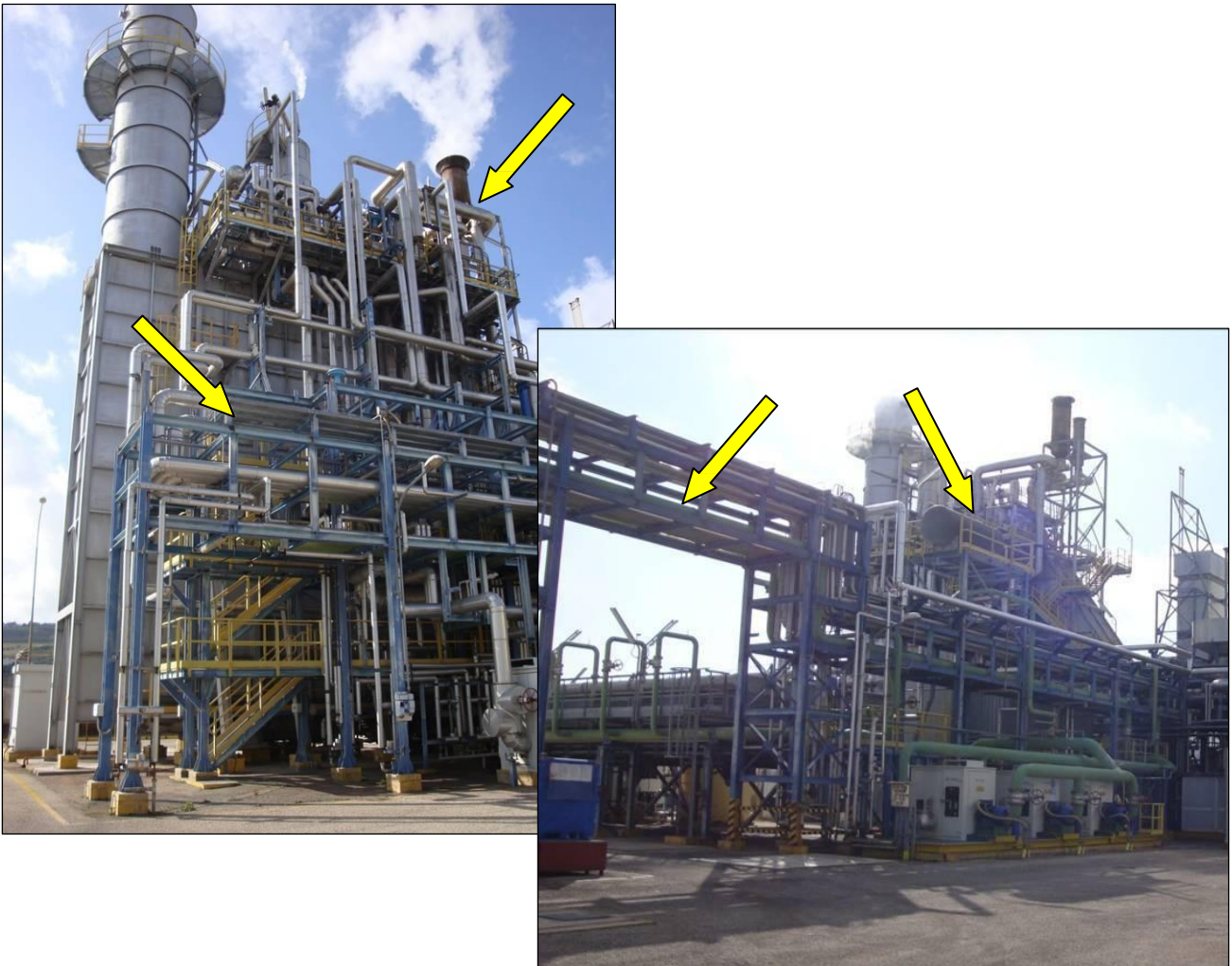
Immagine con individuazione di alcune strutture da rimuovere
