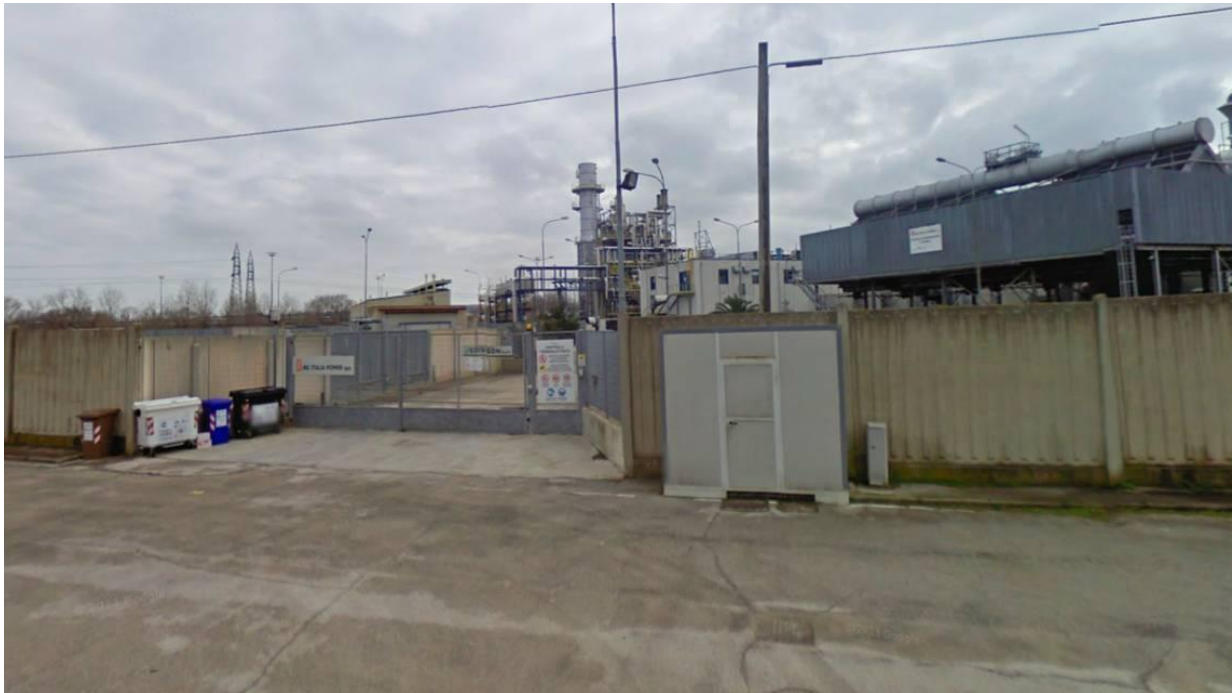
Foto N. 1- Ingresso della Centrale
