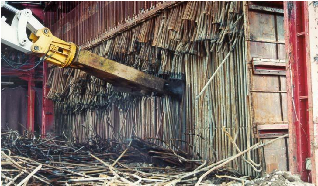
Demolizione meccanica dei fasci tubieri
