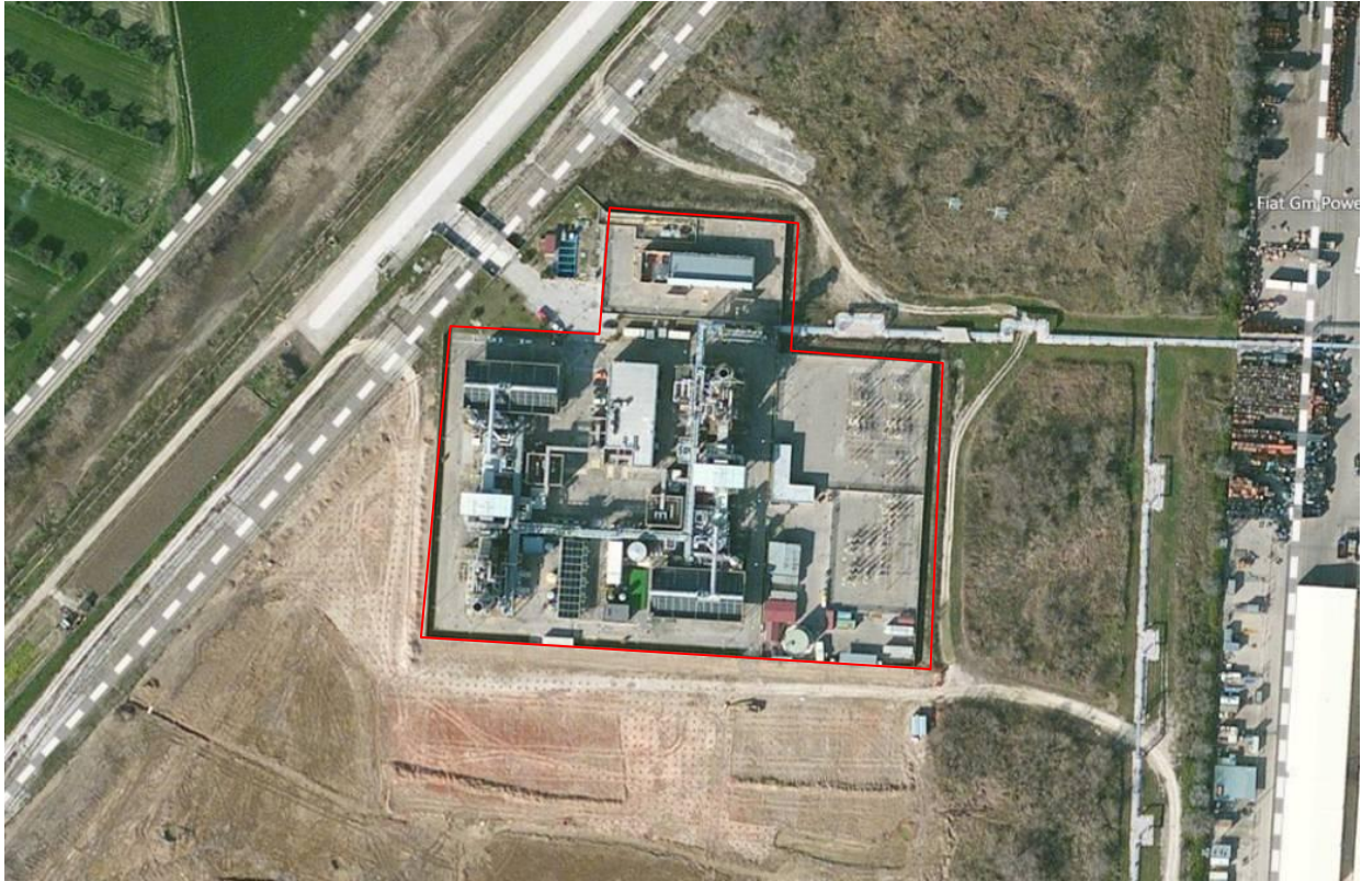
Vista dall'alto della Centrale
