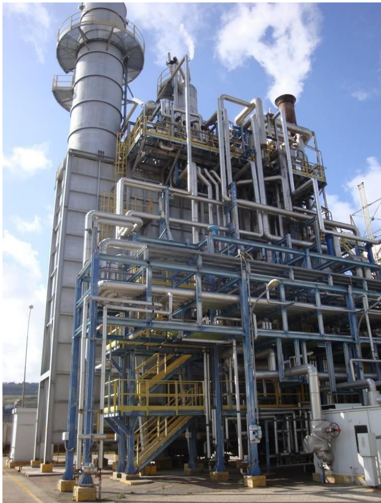
Vista impianti - Coibentazioni
