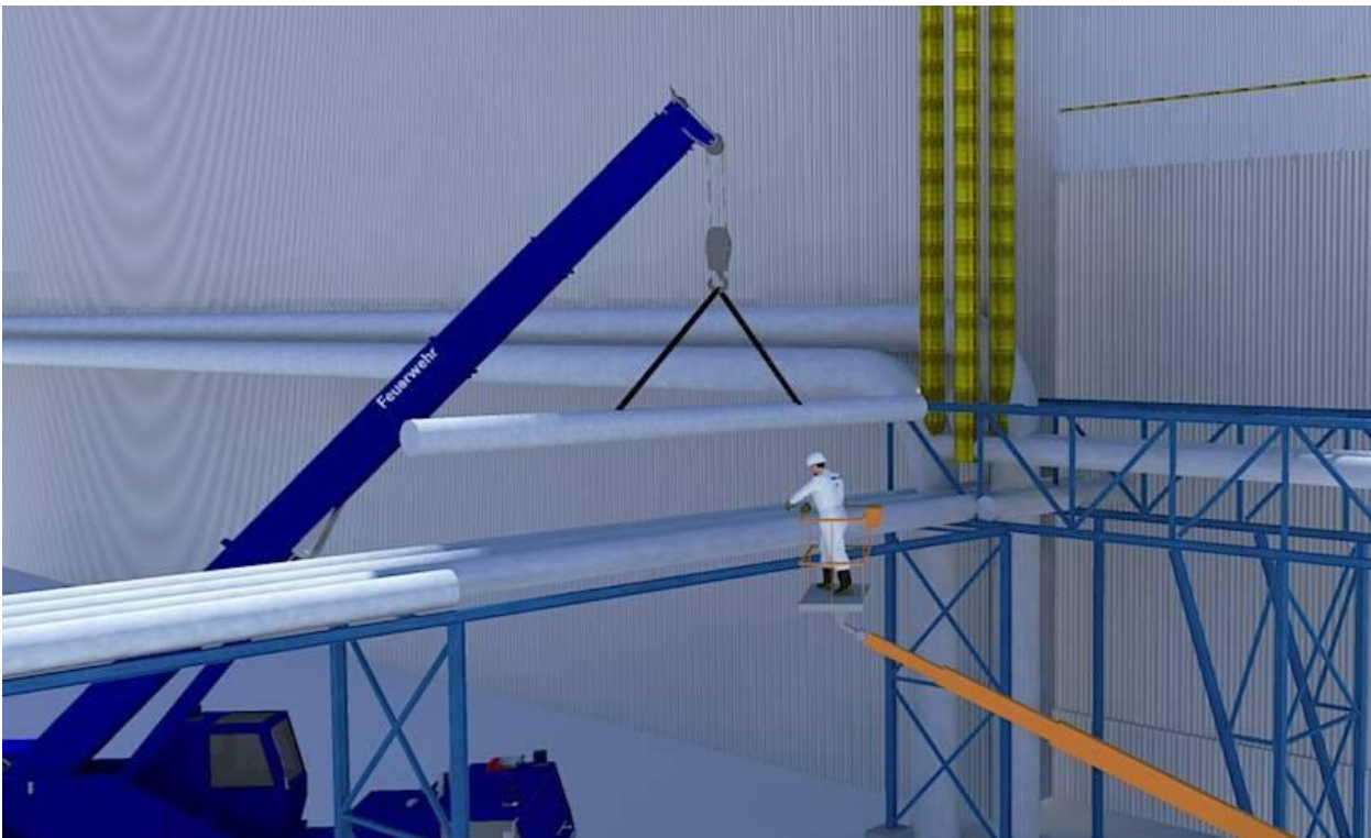
Sezionamento tubazione, sollevamento e calo a terra
