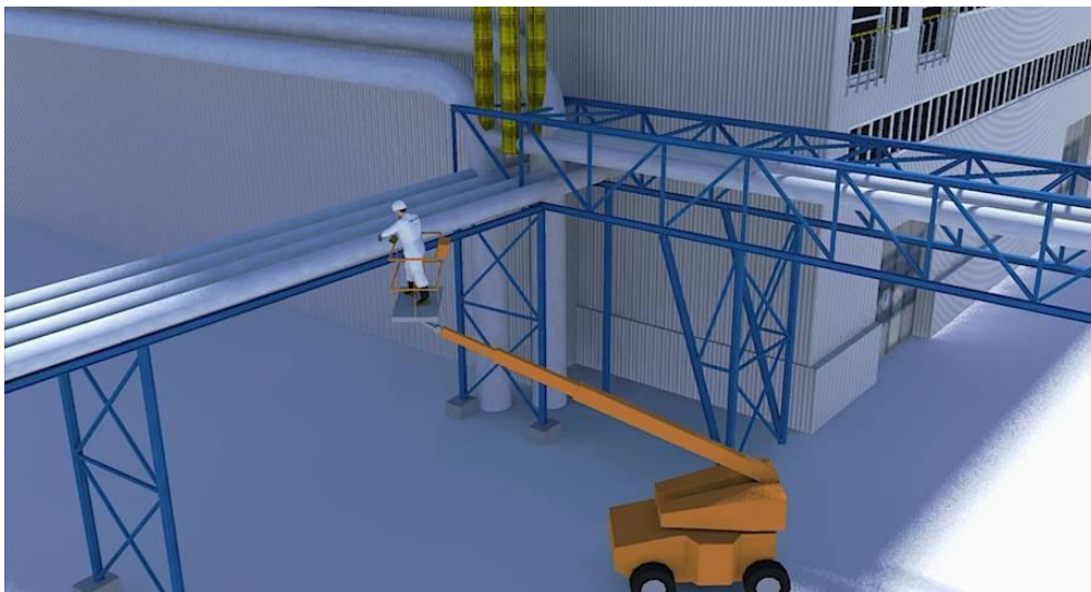
Accesso in quota tramite piattaforma aerea
