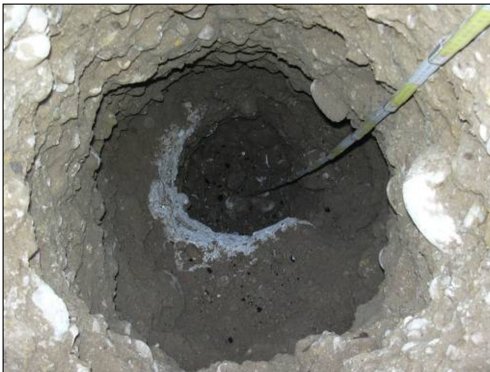
Figura.33 Prescavo SB01 (2.1m)
