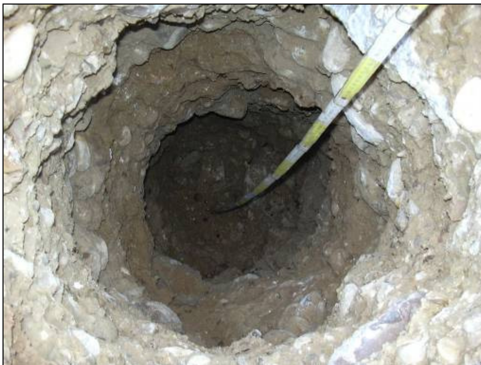
Figura.35 Prescavo SB02 (2,1m)
