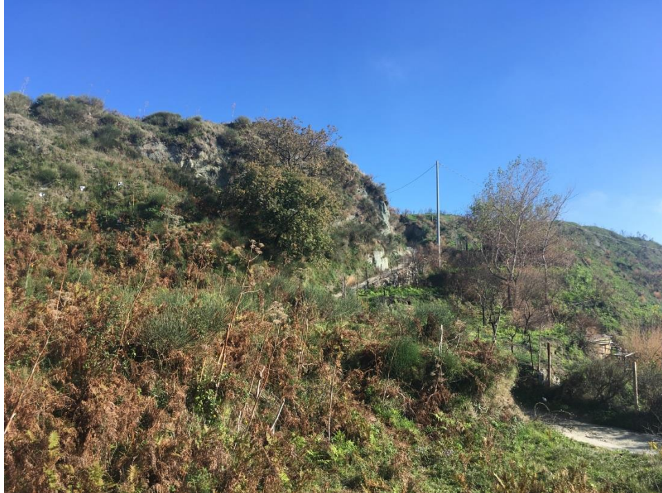
IMG. 5 Versante AREA 3
