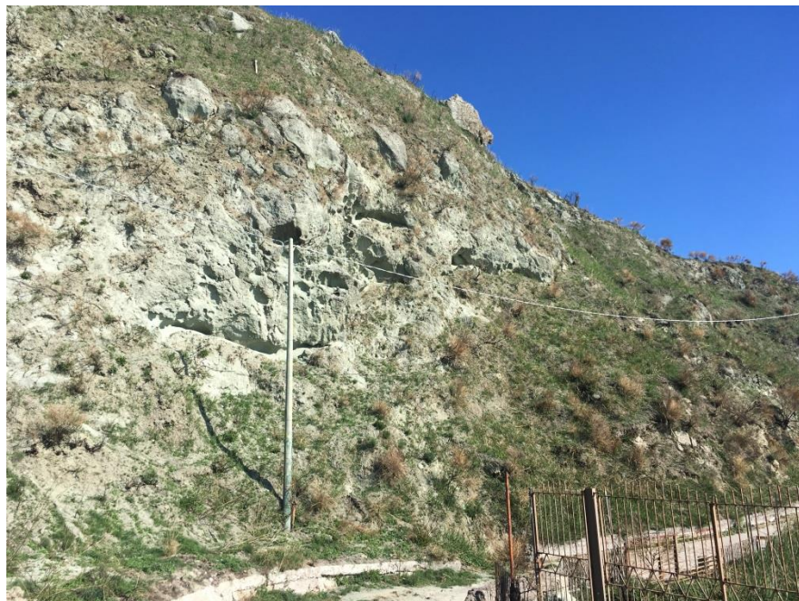
IMG. 2 Versante AREA 1
