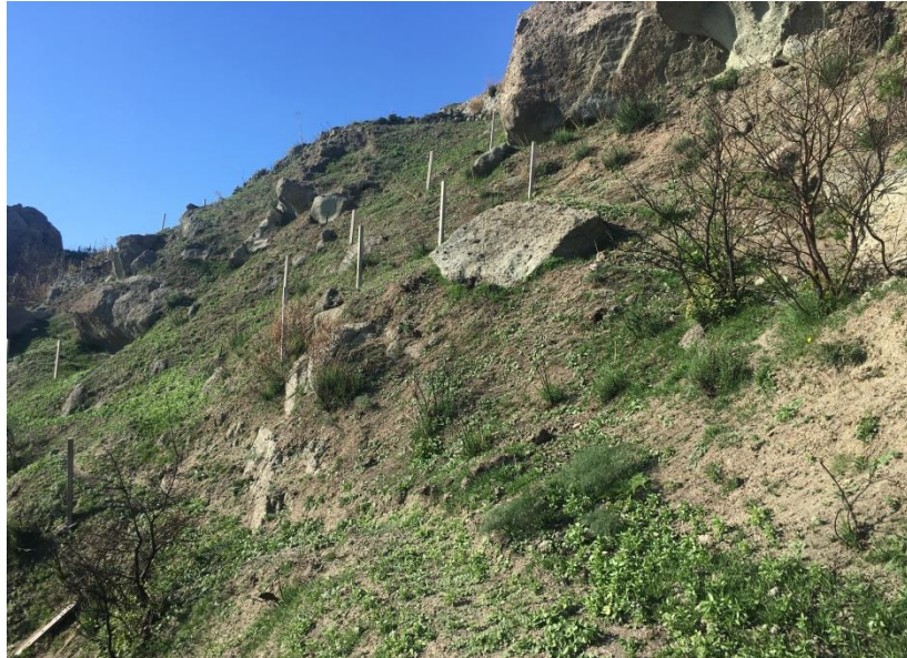
IMG. 3 Versante AREA 2
