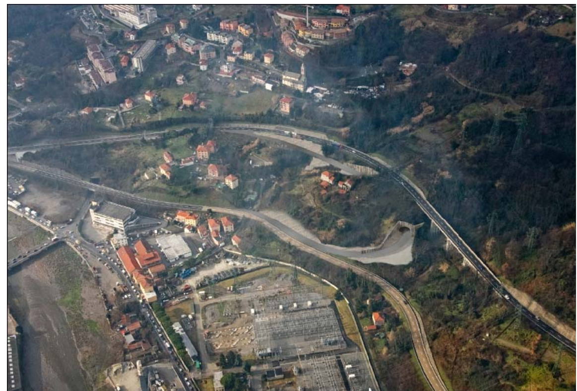
Figura 10-45 Area di cantiere Bolzaneto – simulazione corso d'opera
