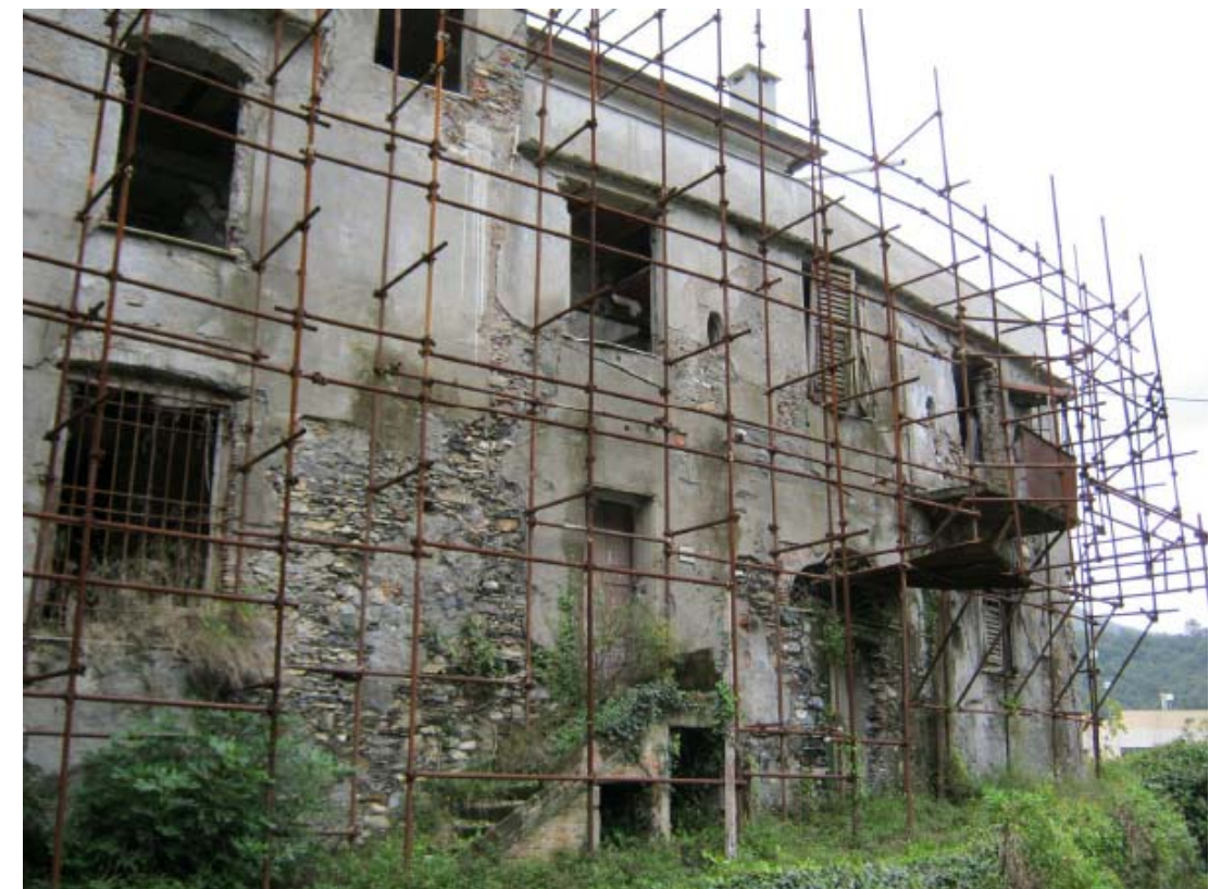
Figura 10-7 Palazzo Pareto - Esterni
