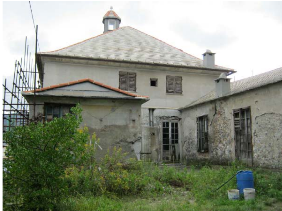
Figura 10-5 Palazzo Pareto - Esterni
