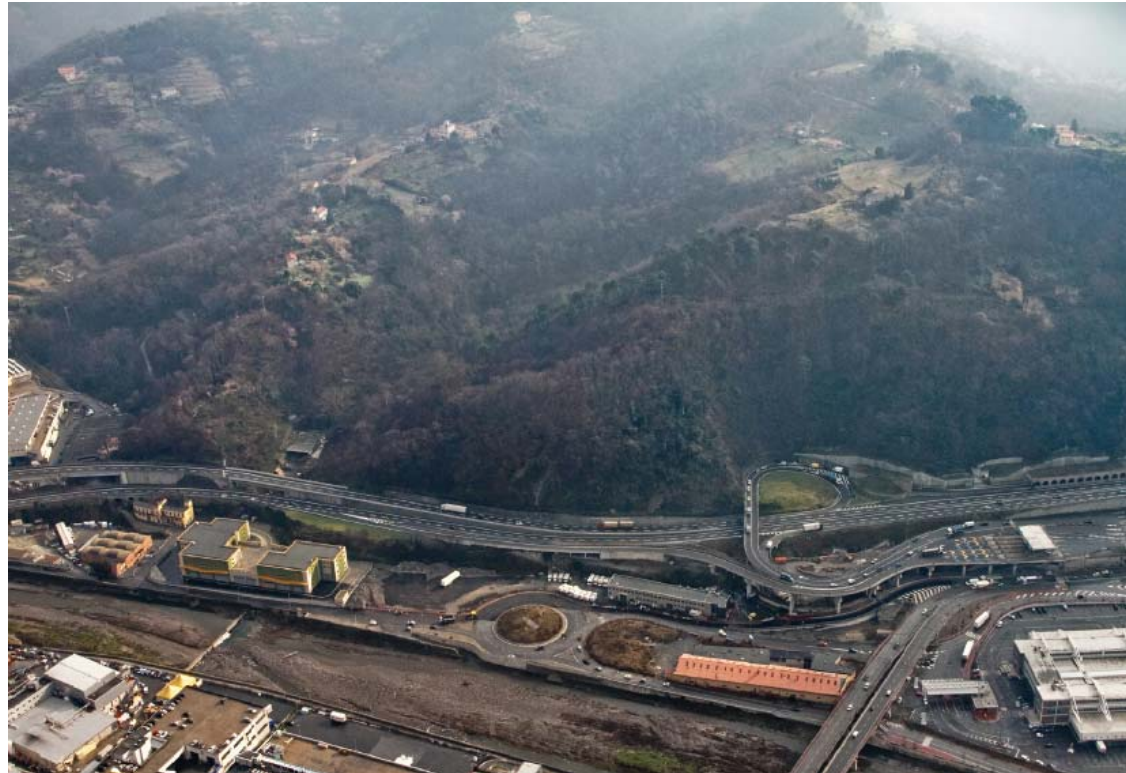
Figura 10-42 Area di cantiere Bolzaneto – stato ante operam
