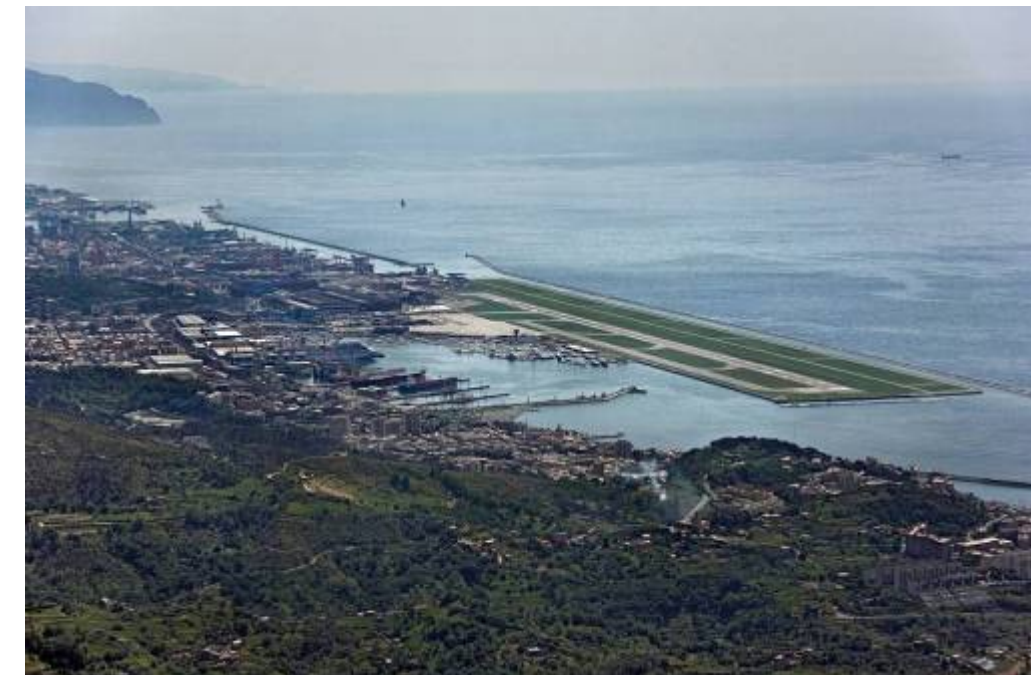
Figura 10-55 Vista aerea dell'area del canale di calma: situazione a progetto realizzato
