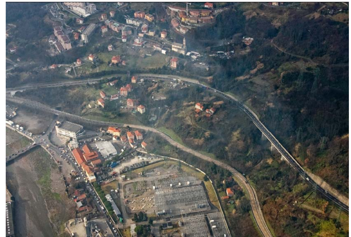
Figura 10-44 Area di cantiere Bolzaneto – stato ante operam
