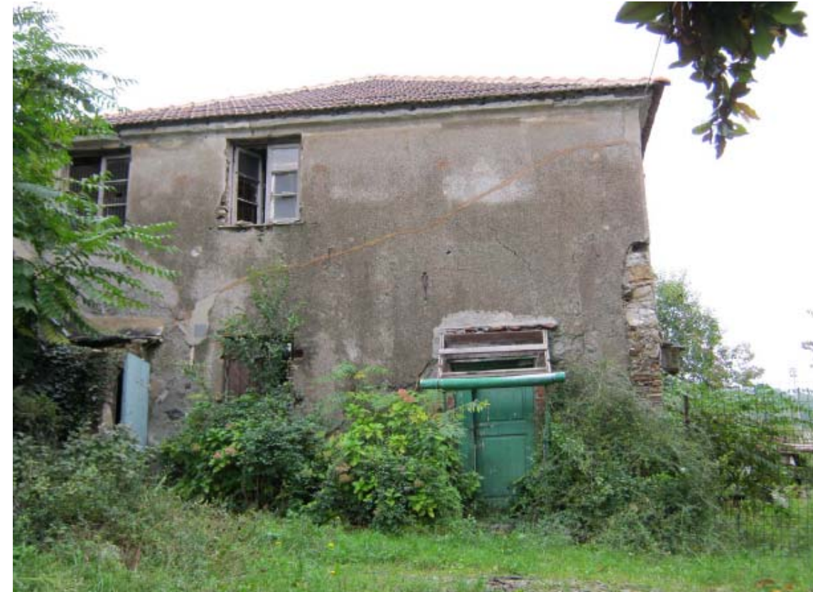
Figura 10-6 Palazzo Pareto - Esterni
