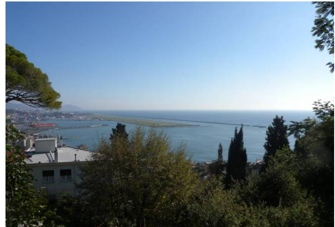
Figura 10-35 Vista da vetta di Pegli - La particolare angolazione permette una buona visibilità della zona di intervento
