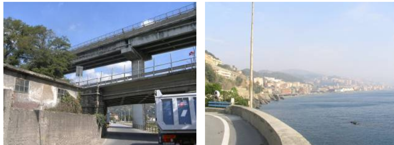
Figura 10-13 Elementi infrastrutturali ed edificazioni lungo la costa
