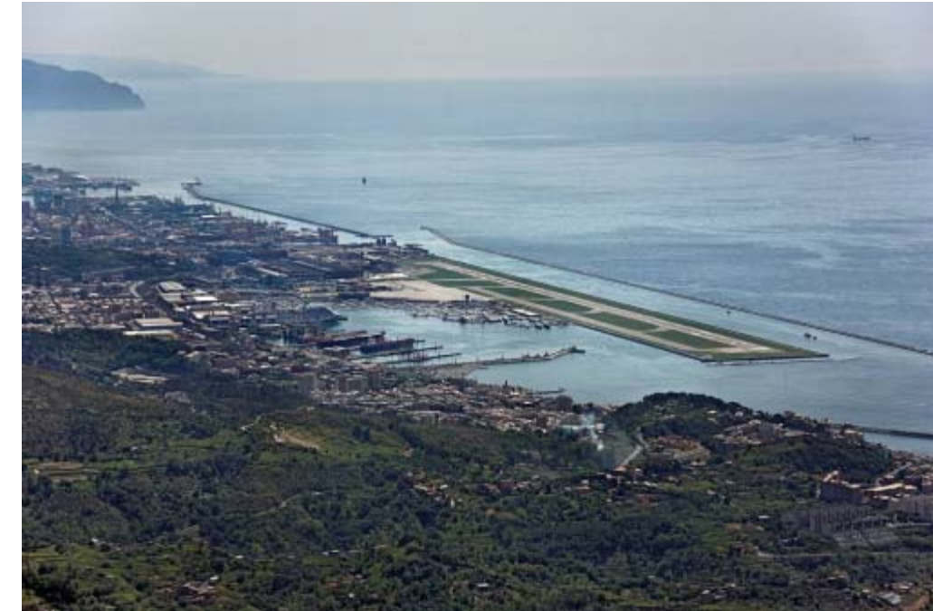
Figura 10-54 Vista aerea dell'area del canale di calma
