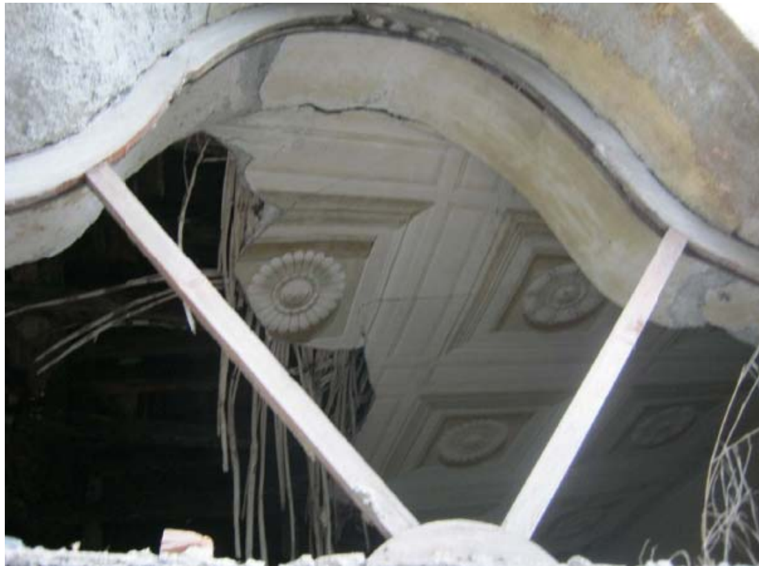
Figura 10-8 Palazzo Pareto - Interni
