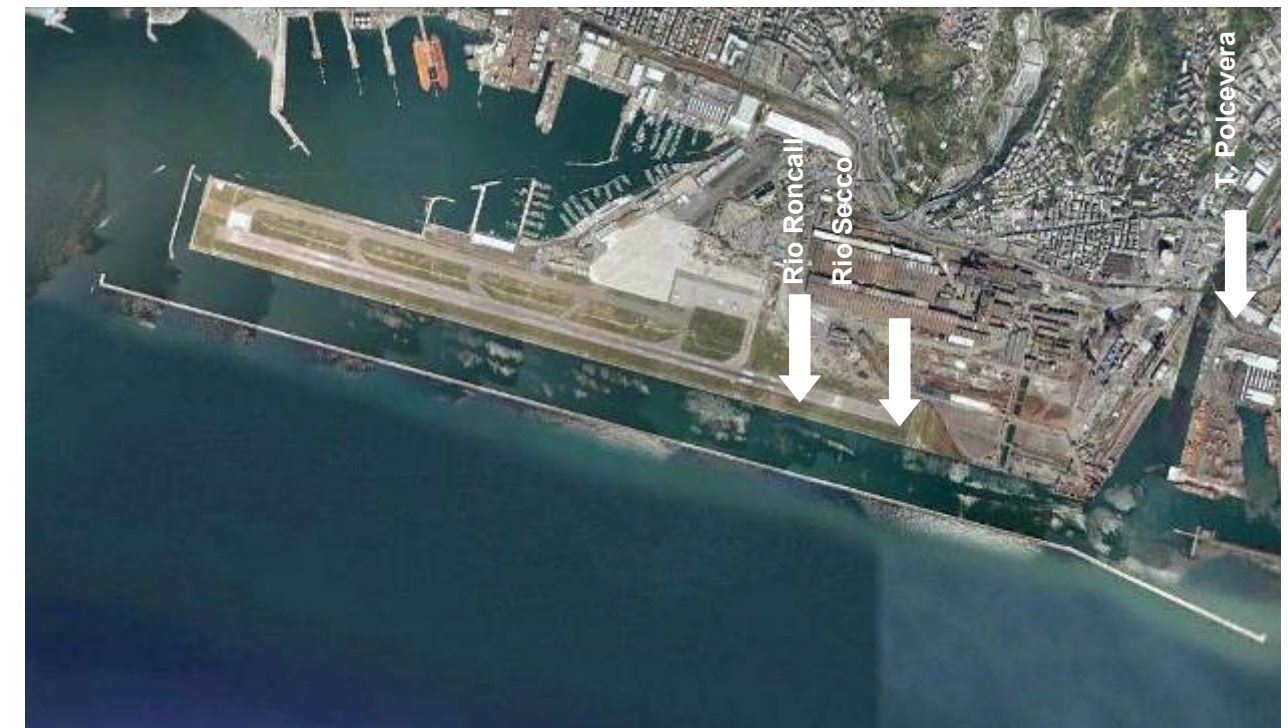
Figura 3-7 Corsi d'acqua che sfociano in prossimità dell'opera a mare
