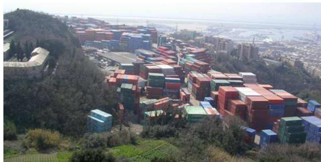
Figura 10-25 Collina degli Erzelli - a sinistra Villa Negrone con il suo parco, a destra containers. Attualmente si sta realizzando il progetto di riconversione dell'intera area
