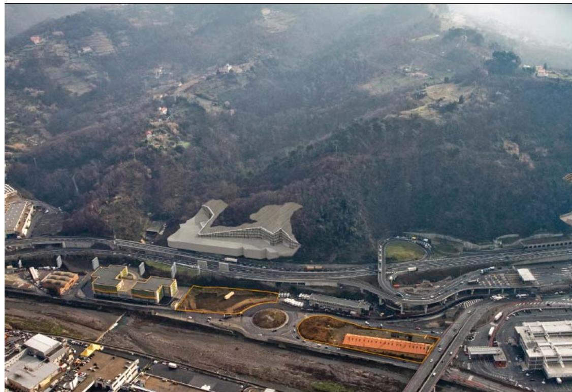
Figura 10-43 Area di cantiere Bolzaneto – simulazione corso d'opera
