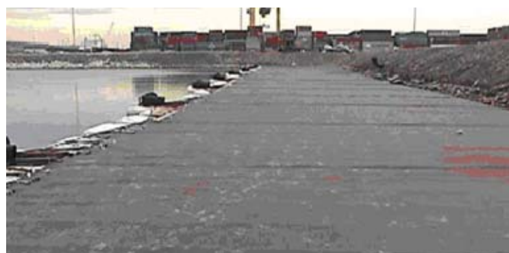
Figura 5-35 Piattaforma galleggiante modulare
