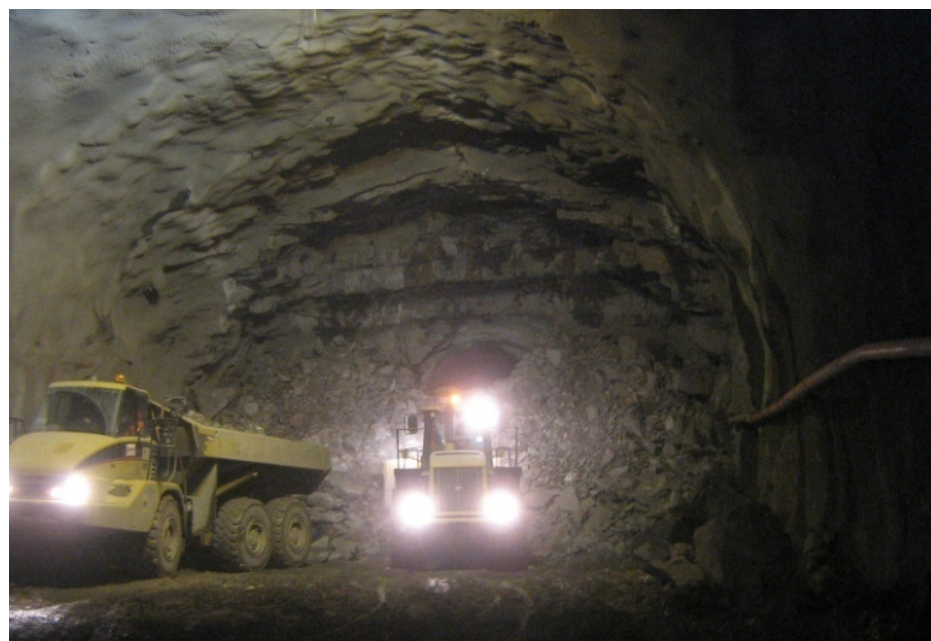
Figura 4-7 – Smarino della volata nello scavo con esplosivo
