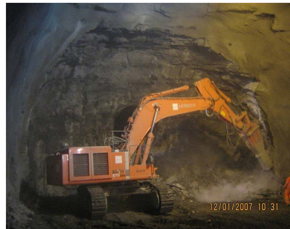
Figura 4-8 – Abbattimento del fronte con martellone
