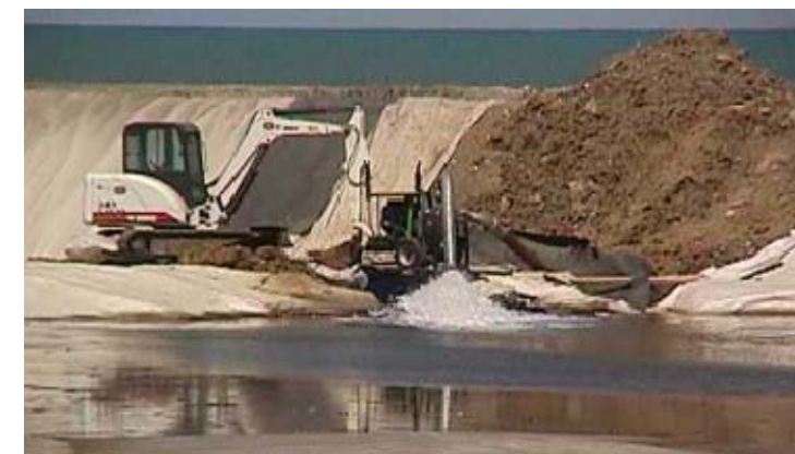
Figura 5-37 Fasi di pompaggio dell'acqua per l'affondamento del capping
