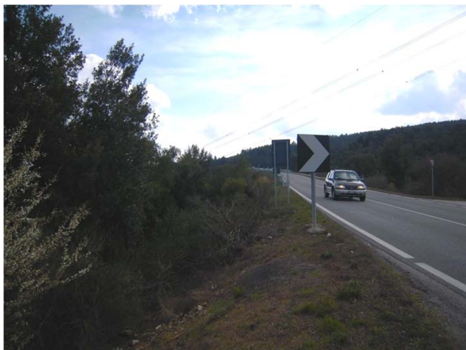
Figura 9:Foto 4 – Fine viadotto "La coscia" - Vista verso Grosseto
