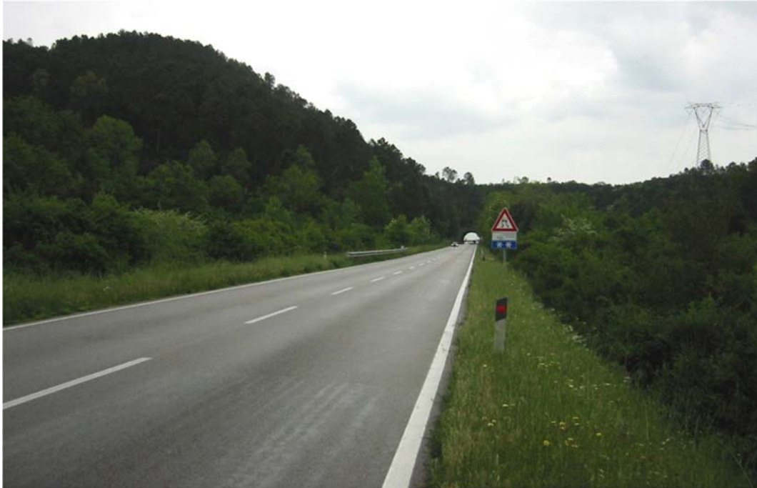
Figura 20: Vista 3 – Stato attuale
