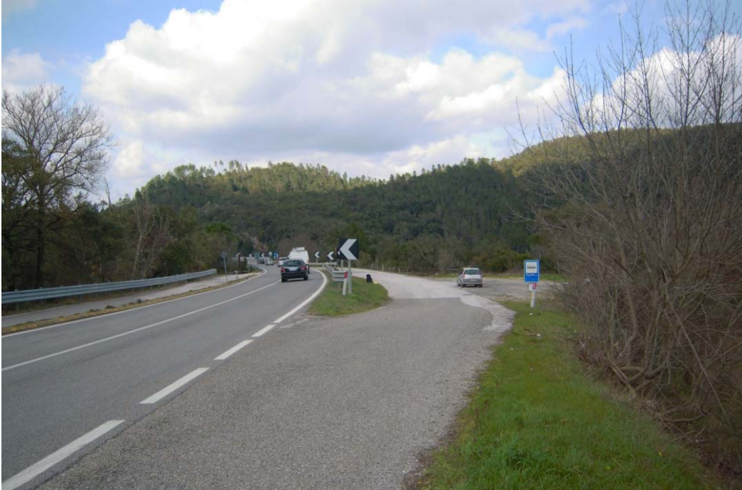
Figura 14: Vista 1 – Stato attuale
