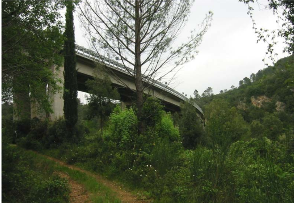
Figura 17: Vista 2 – Stato attuale
