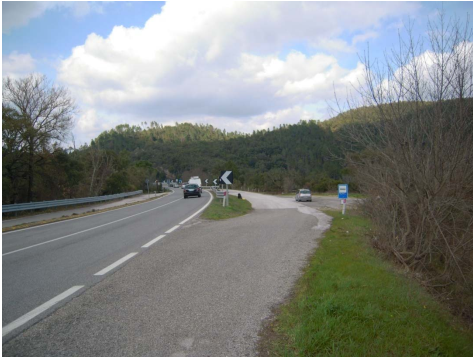
Figura 10:Foto 5 – Imbocco galleria “Poggio Tondo” - Vista verso Siena
