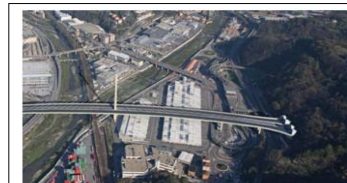
Attraversamento del torrente Polcevera in corrispondenza del mercato ortofrutticolo e dei fiori
