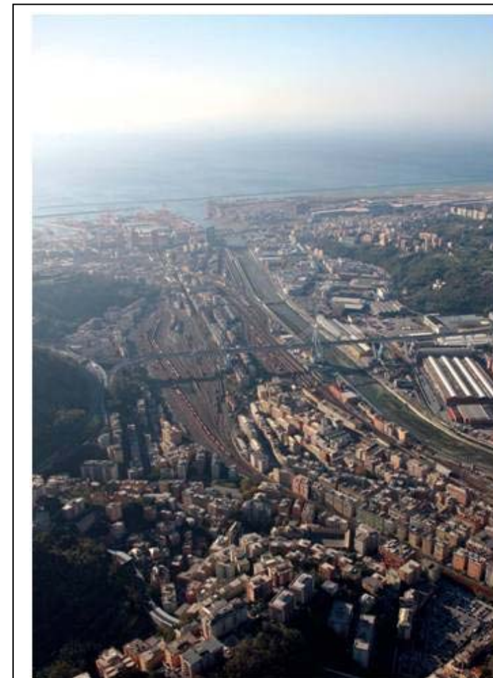
Il "viadotto Morandi" e lo smistamento del nodo autostradale verso Nord, verso Ovest e al centro città. È un punto di particolare criticità che rappresenta in molte occasioni una "impedenza" per l'intero sistema dell'area ligure, vista anche la compresenza di altre importanti infrastrutture di trasporto (ferroviarie e portuali)
