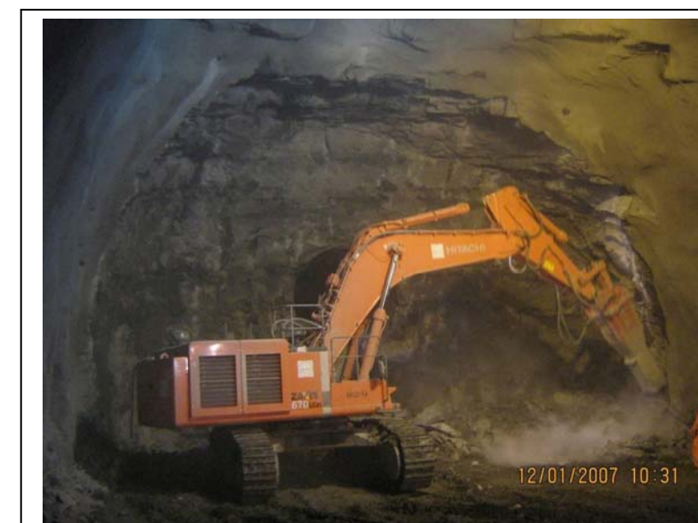
Modalità di scavo tradizionale
