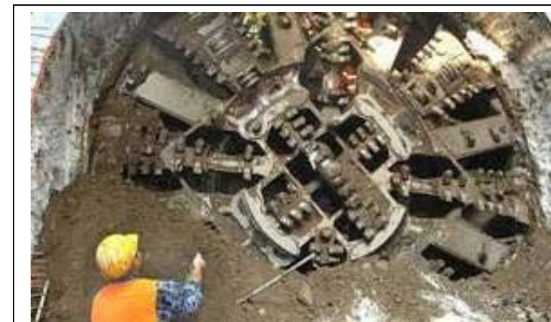
Modalità di scavo con TBM (Tunnel Boring Machine)
