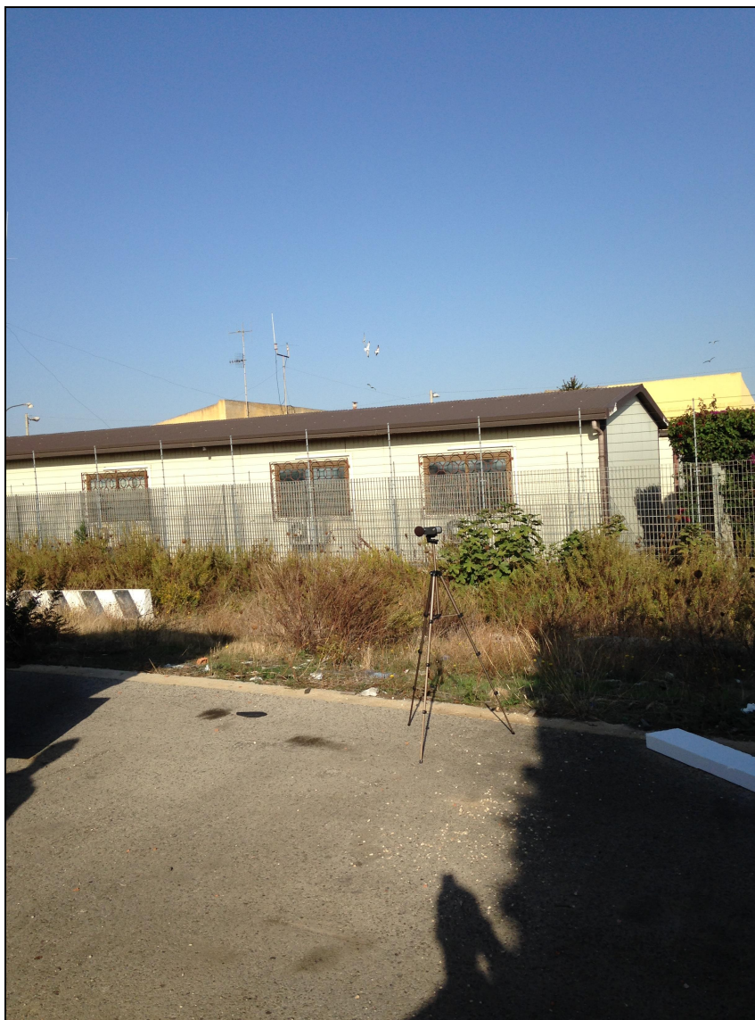
Vista della postazione di misura RSP2
