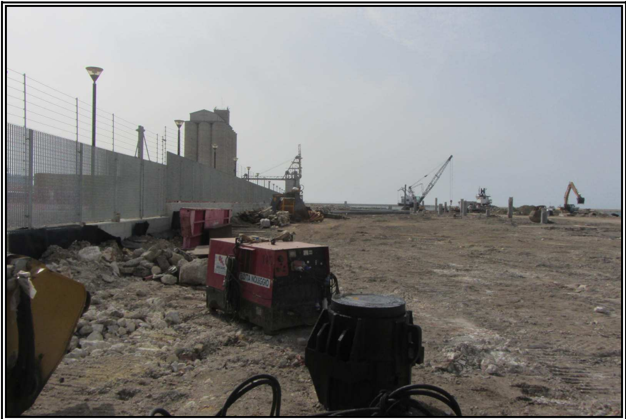
Figura 4: Veduta nuova recinzione di delimitazione dell'area di security.
