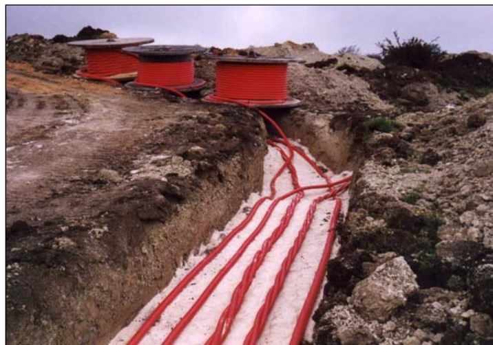
Particolare posa cavi elettrici
