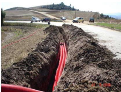
Fig. 1.3 - Foto illustrativa della messa in posa dei cavidotti MT
