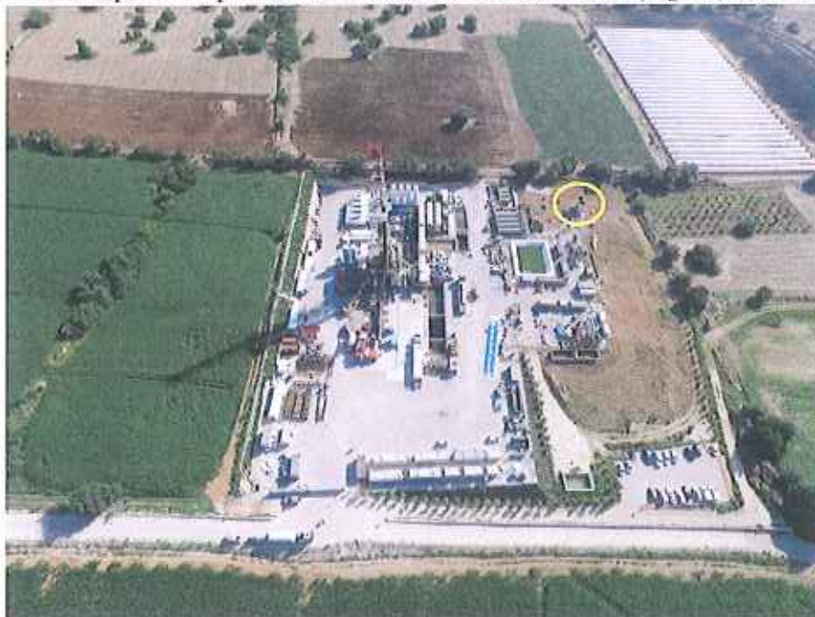
Figura 3- Vista della piazzola di perforazione e della ubicazione della Fiaccola (in giallo). Fonte: Irmínio Srl.
