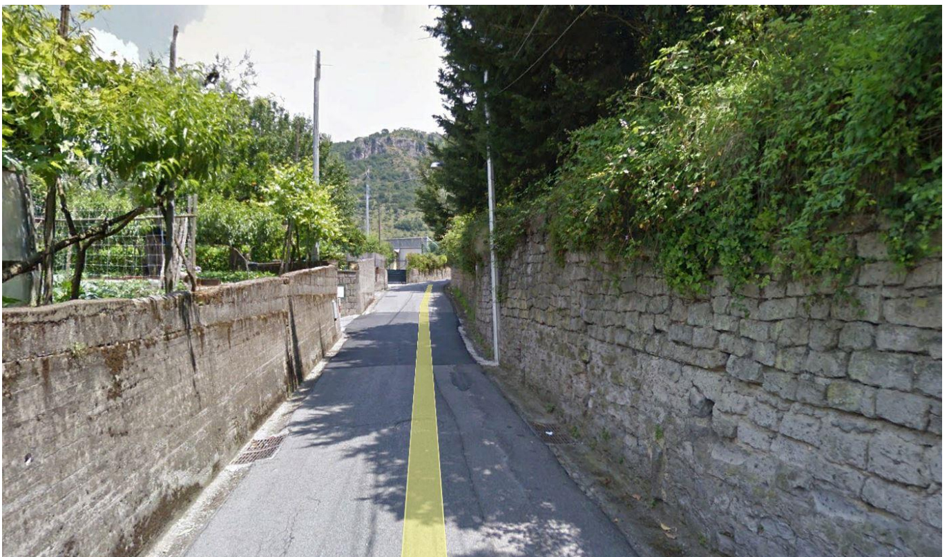
Figura 6: Tratto in cavo 150kV lungo Via Lavinola.
