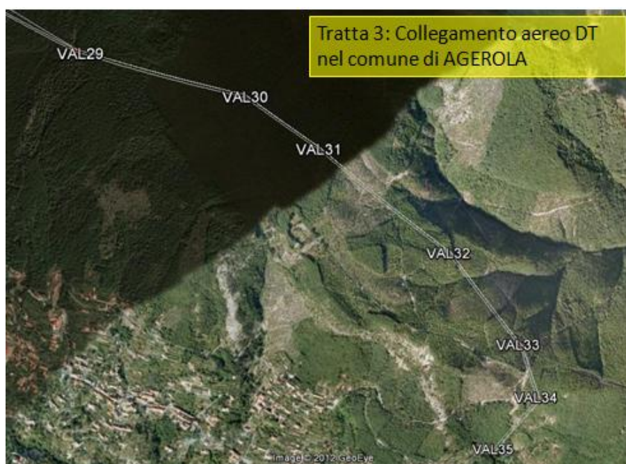
Figura 7: Linea aerea 150 kV DT in direzione sud comune nel di AGEROLA.
