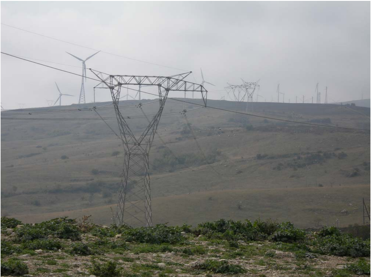
Foto 2 - Area al confine tra Campania e Puglia interessata dalla linea attuale, che verrà sostituita
