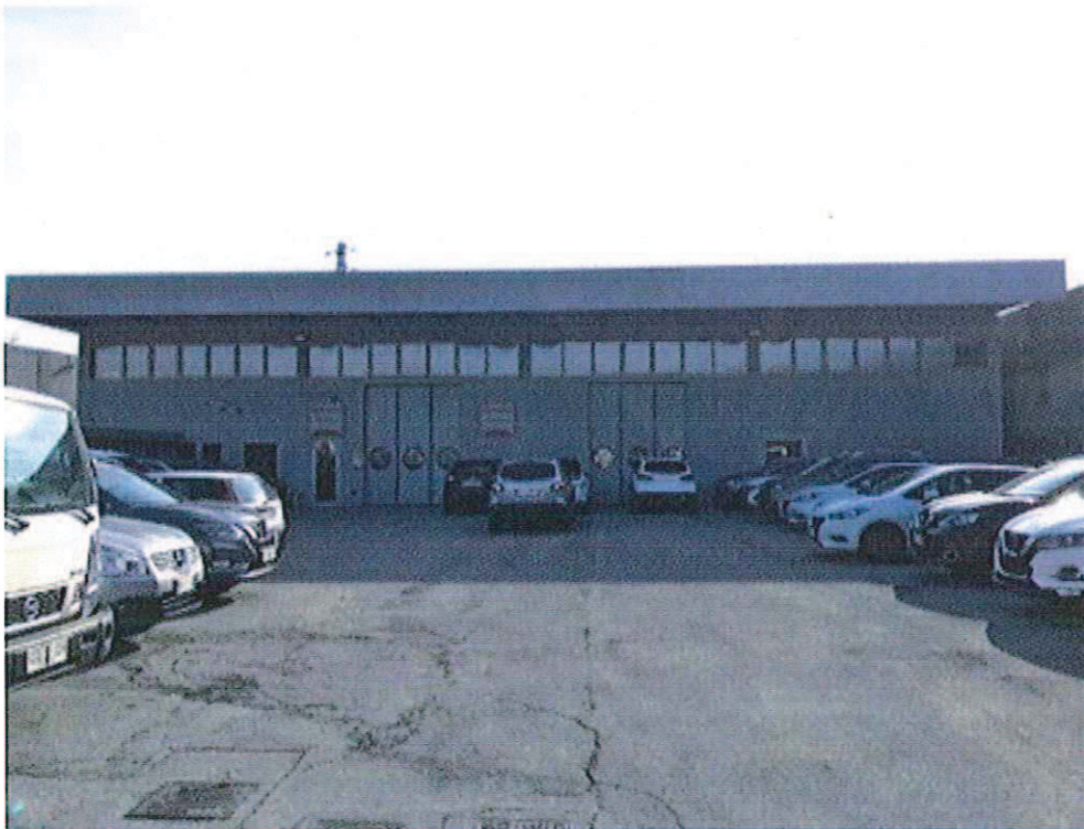
Immagine 5 - edificio 3 - officina
