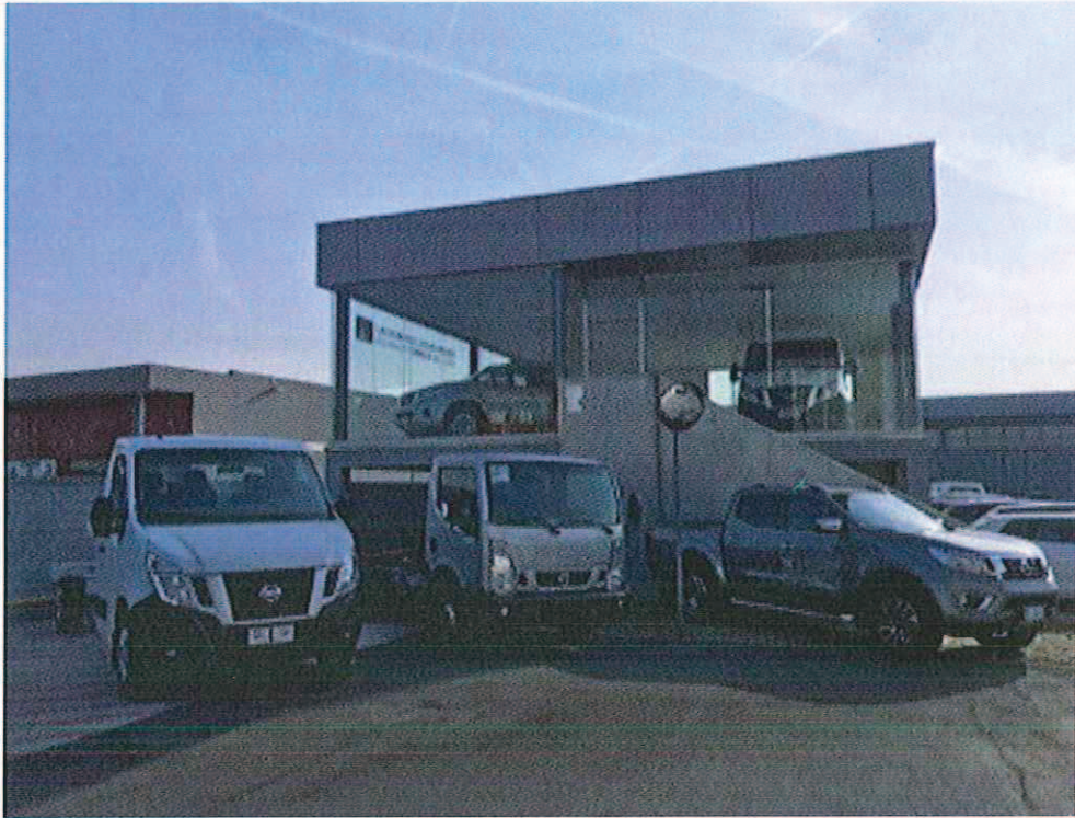
Immagine 4 - edificio 2 - esposizione
