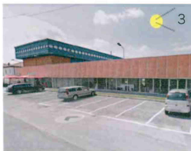
Foto Google Maps - capannone abusivo successivamente condonato e ampliato con autorizzazione comunale - Moletta
