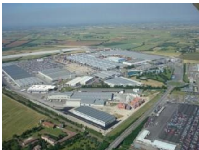
Figura 54 – Interporto di Rivalta, prossimo all'area di cantiere CA03
