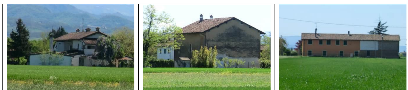
Figura 15 - Edifici a sud dell'area di cantiere
